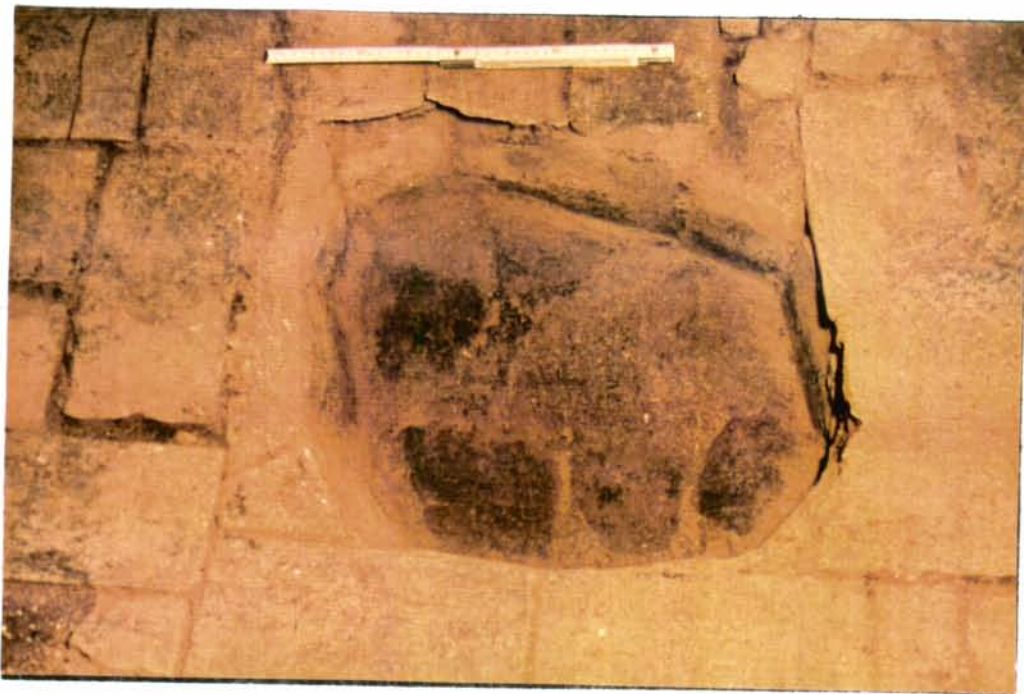
Cubeta localitzada al centre de la pavimentació de l'estructura 1 (U.E. 34).
