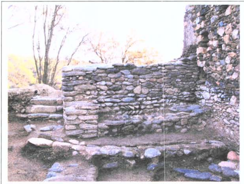
El MR-9 després de la rehabilitació
