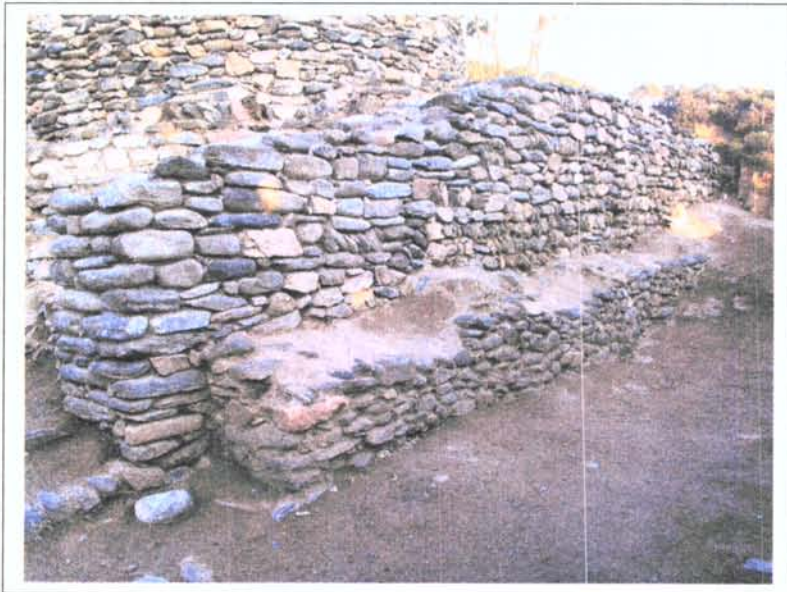
Vista frontal del MR- 16. La part del final (dreta) ha estat coronada, mentre que la part esquerra s'ha arranjat degut a un desolom.
