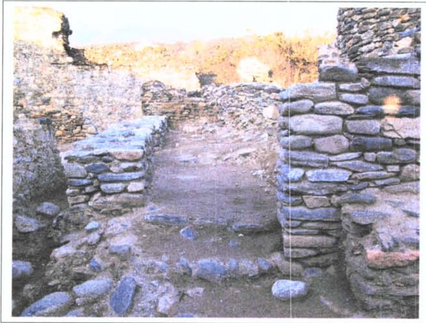
Vista de les cantoandes rehabilitades dels murs MR 15 i 16
