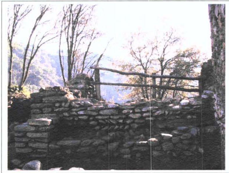
Panoràmica frontal del parament MR 9 abans de la rehabilitació.
