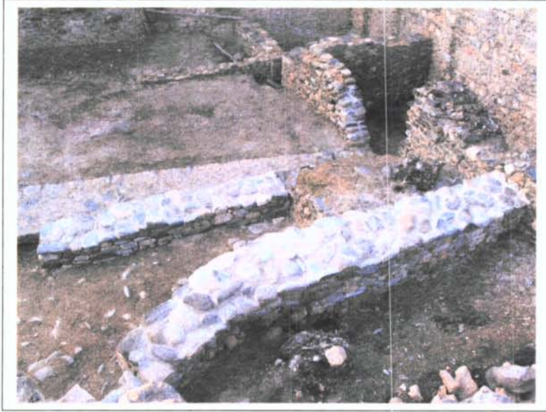
Vista de MR- 16 després de la seva coronació i del MR- 17 després de la seva consolidació.
