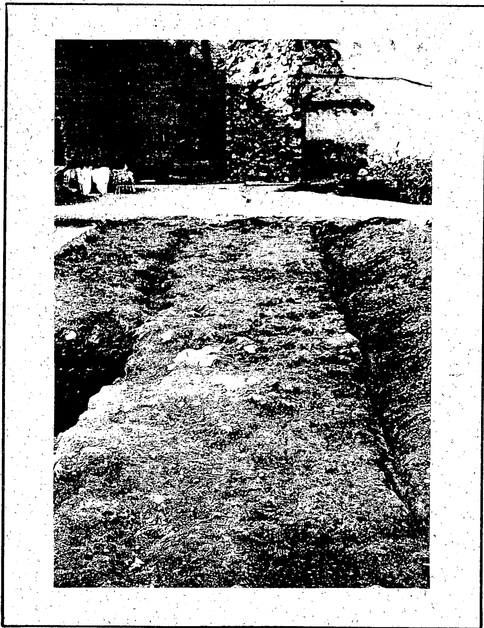
5- Tram de la muralla Medieval afectat.
