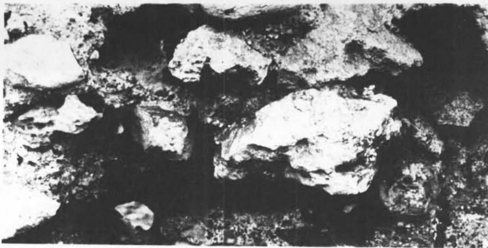
13.- Detall del parament del mur amb les marques d'un possible encofrat.
