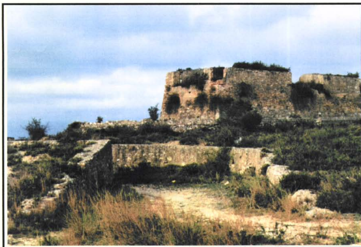
Accés principal – abans d'iniciar les tasques de neteja i restauració
