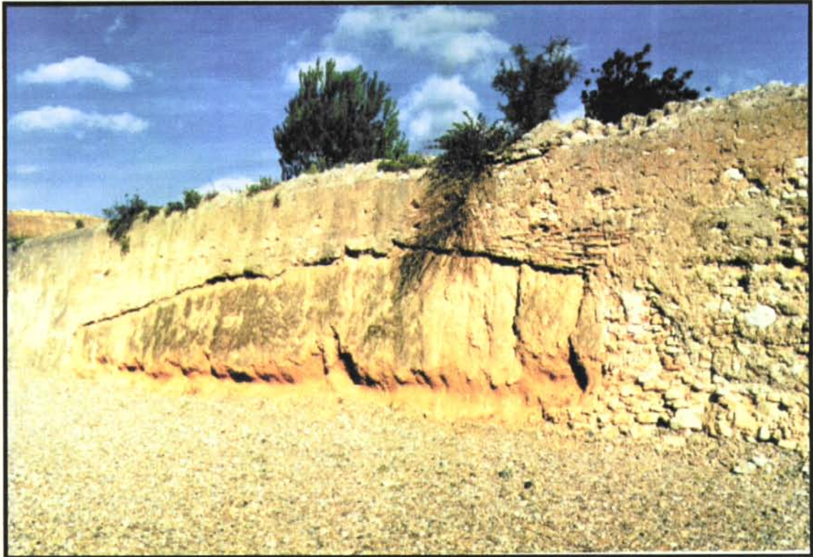
Detall de la contraescarpa del fossat principal, tallat al substrat natural
