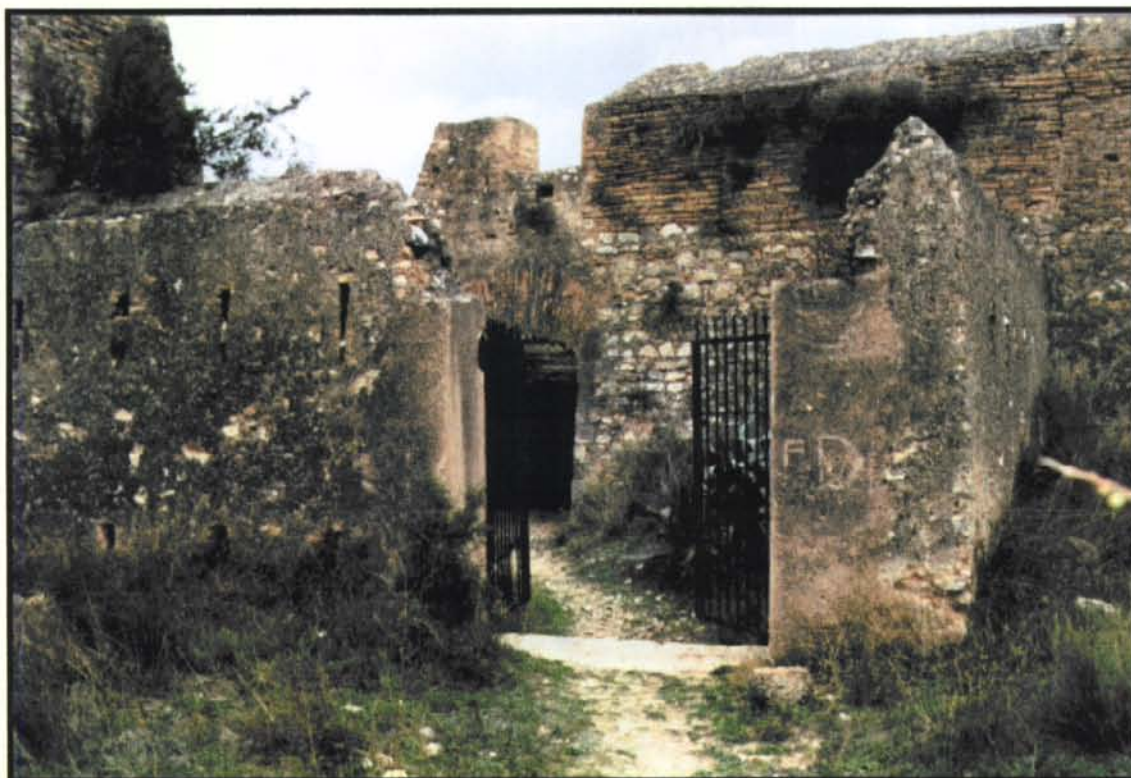
Accés al reducte de l'anomenat "cos de guàrdia". Es poden observar els dos nivells d'espitlleres
