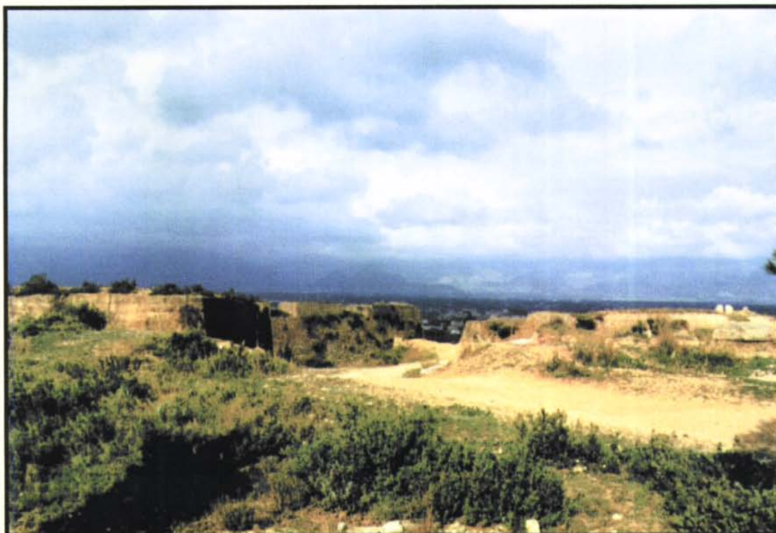
Vista de l'estat de conservació del camí cobert (sector oest), al fons el revellí.
