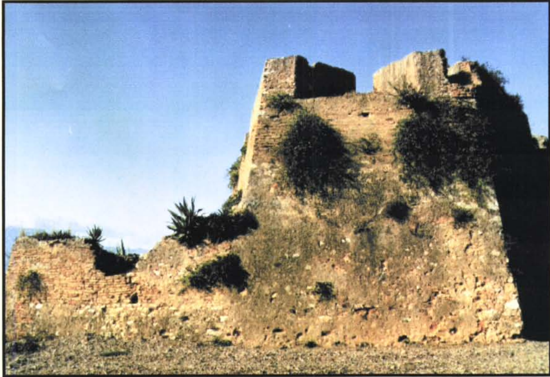
Vista del baluard est de la segona avançada, al peu del fossat principal
