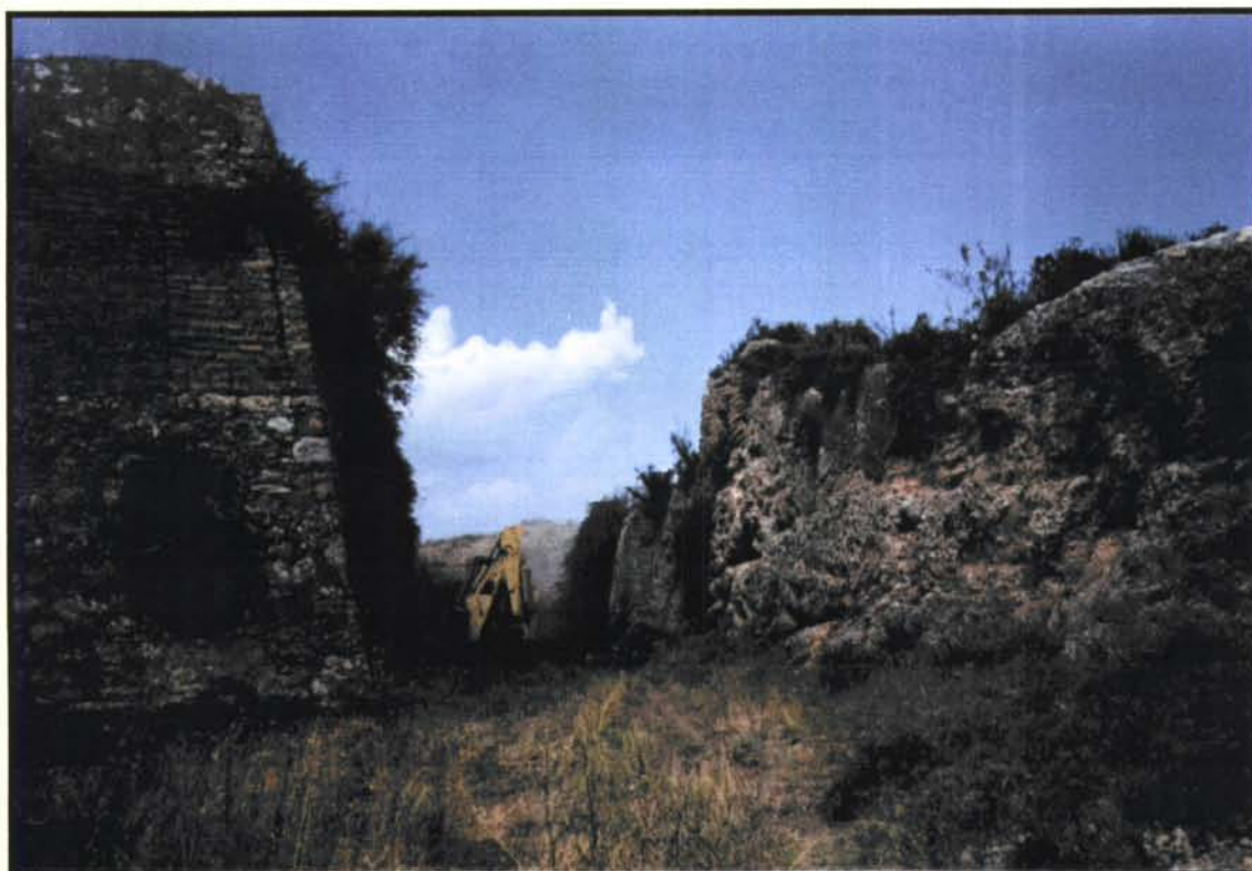
Vista del fossat principal, procés de neteja superficial de vegetació i escombros
