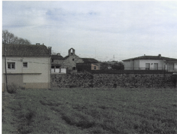
Vista des de l'exterior del mur perimetral de la comanda
