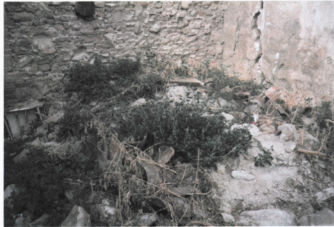
Detall de l'habitació B abans d'iniciar-se les obres de neteja de la runa originada amb l'esfondrament de la volta
