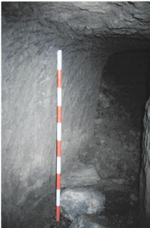
Detall d'un tram de la galeria 215
