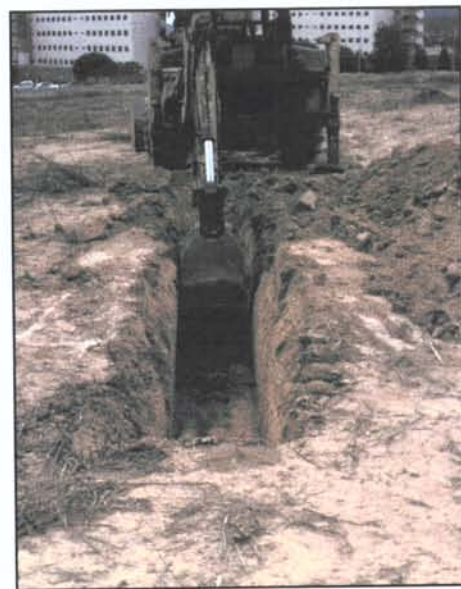
Procés d'execució d'una de les cales
