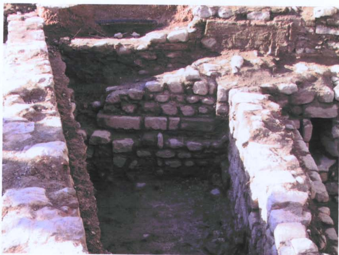
Fig.3. Vista de l'àmbit 1. Part interna de la façana
