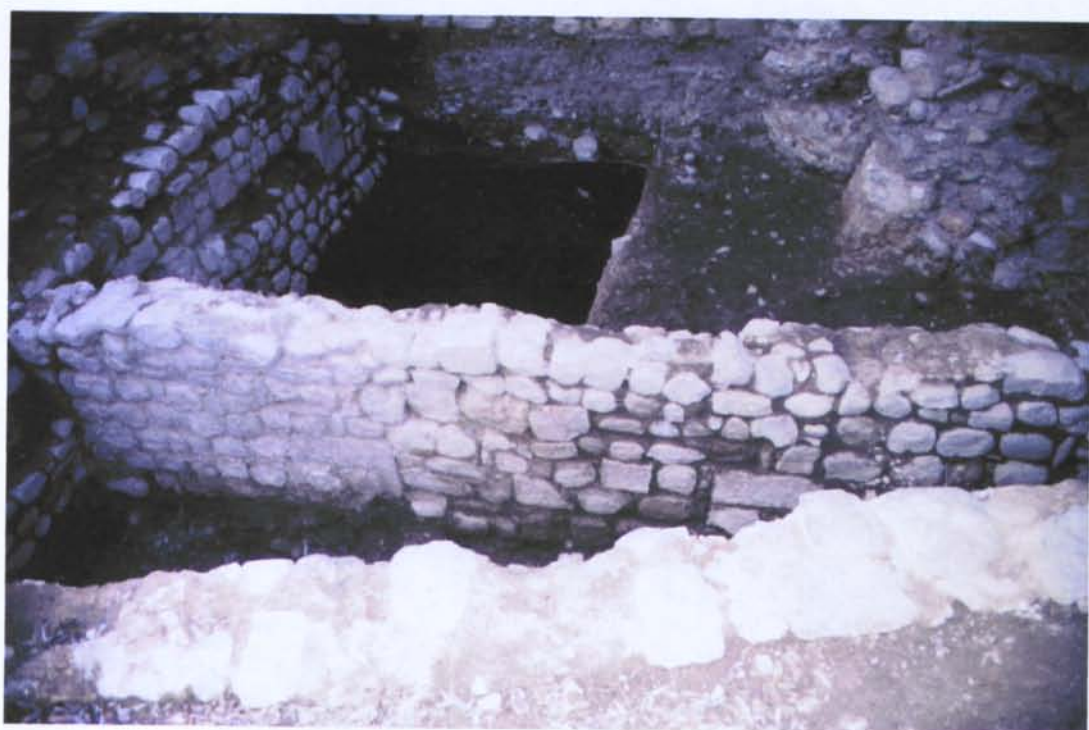
Fig. 4. Mur de separació entre els àmbits 1 i 2. (UE 1022), amb la porta tapiada.
