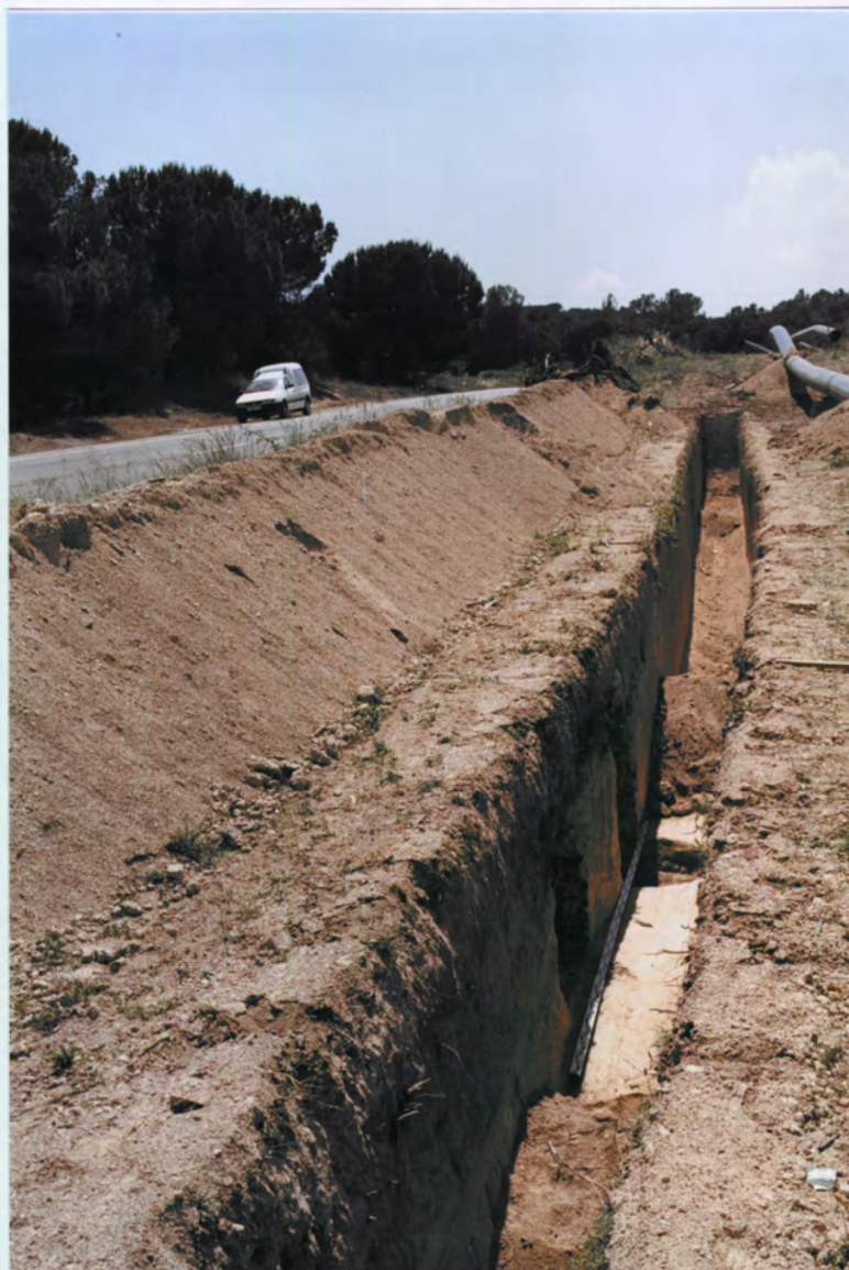
Foto 11. Vista del tram entre el V-B-180 i el V-B-181 (El Cameró II, La Torre de Claramunt)..
