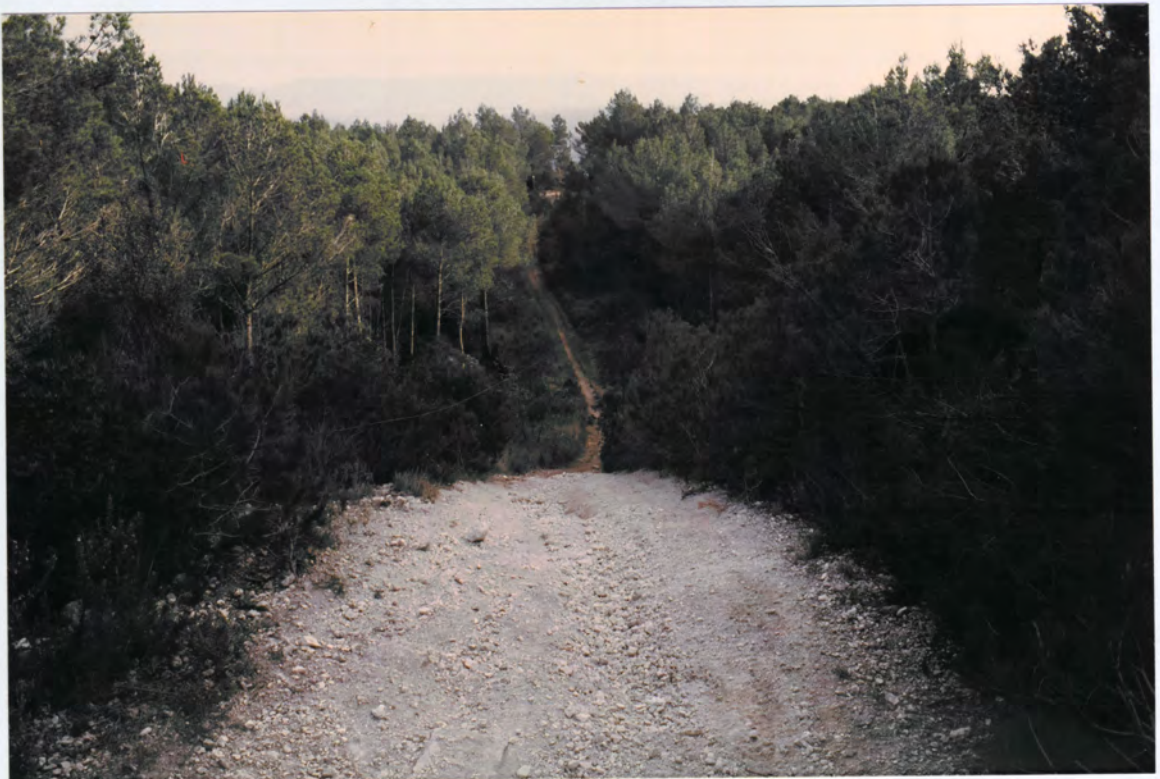
Foto 4. Vista del tram entre el V-B-92 i el V-B-93.
