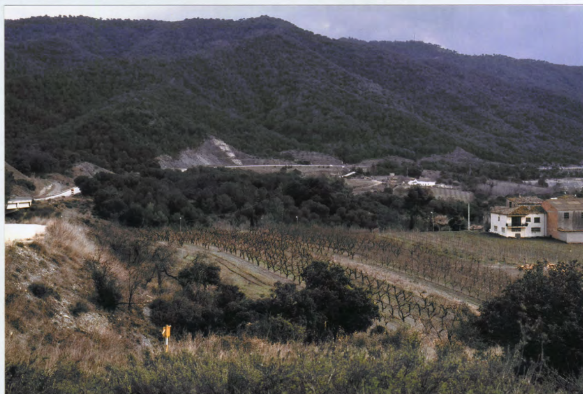
Foto 12. Vista del tram entre el V-B-202 i el V-B-206.
