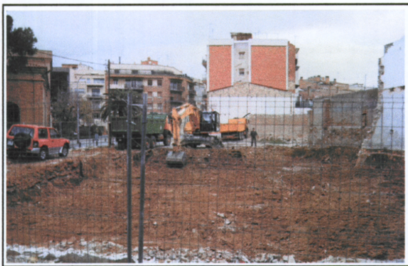
Fotografía del solar de Cal Vila
