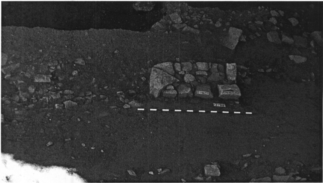
Fot. 3. Detall de la base d'un pilar (UE 1162), situat al mig de l'àmbit 3, que possiblement subjectava un sistema de coberta de l'àmbit durant l'època moderna.
