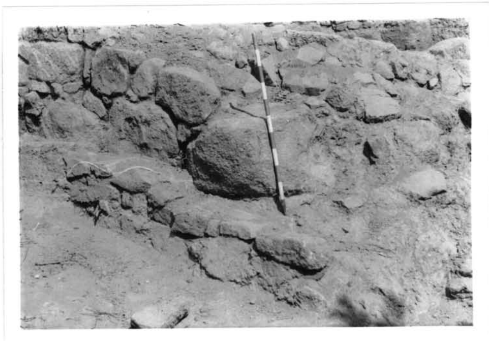
Angle exterior de la muralla i banqueta
