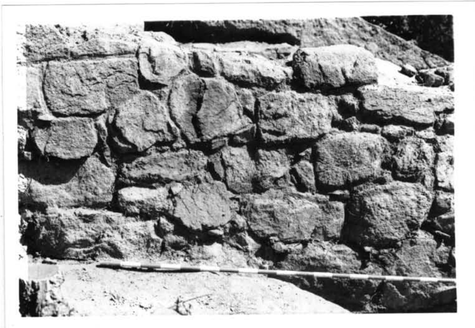
Parament extern de la muralla
