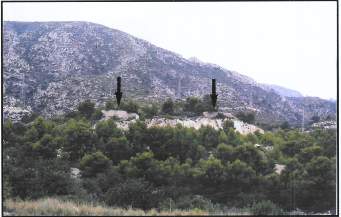
Foto nº 3: muros de contención de un antiguo camino de acceso a los campos de esta zona cuya cronología es indeterminada.
