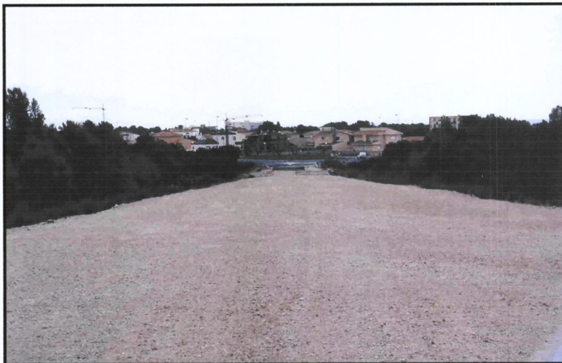
Foto nº 16: PK 7+250 al PK 7+500: Zona con terraplenes donde ya se está trabajando.
