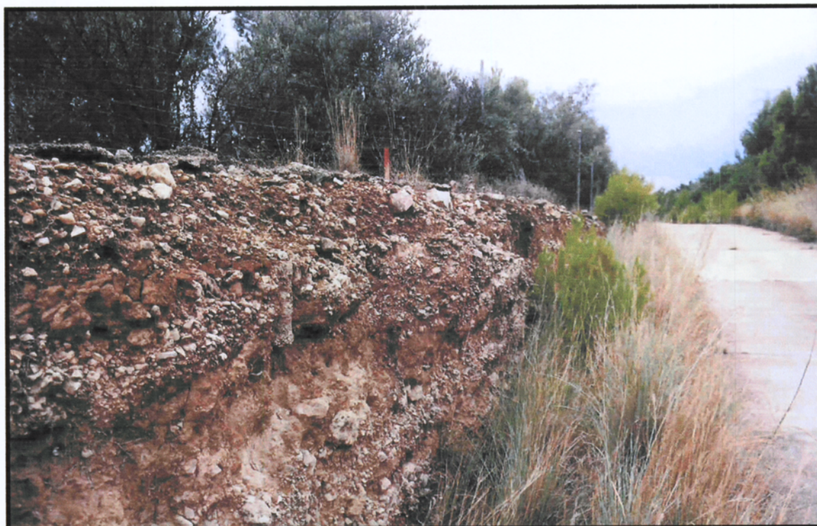
Foto nº 9: PK 2+900: Zona paralela al talud de la Autopista.
