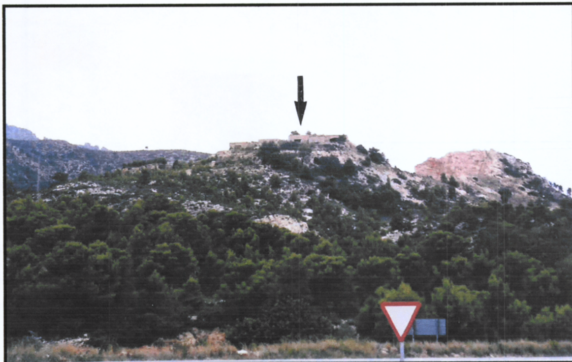
Foto nº 5: Bunquer de Vandellos.
