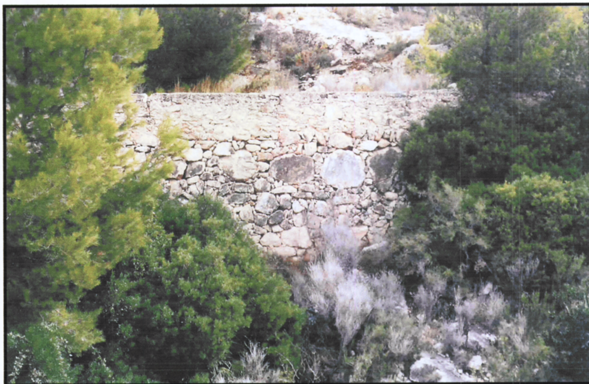
Foto nº 4: detalle de los muros de contención.
