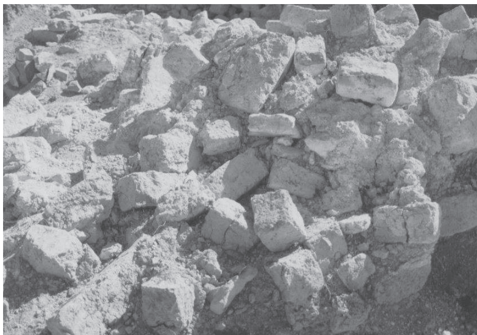
Figura 9. Detall de l'enderroc de tovots.
