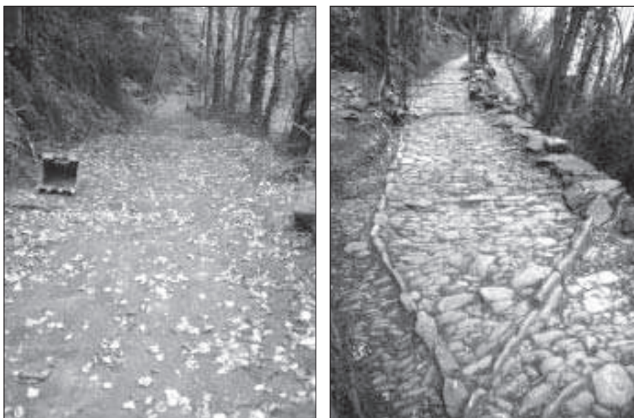
Figura 1. Un tram de les Marrades, abans i després de les obres de rehabilitació
