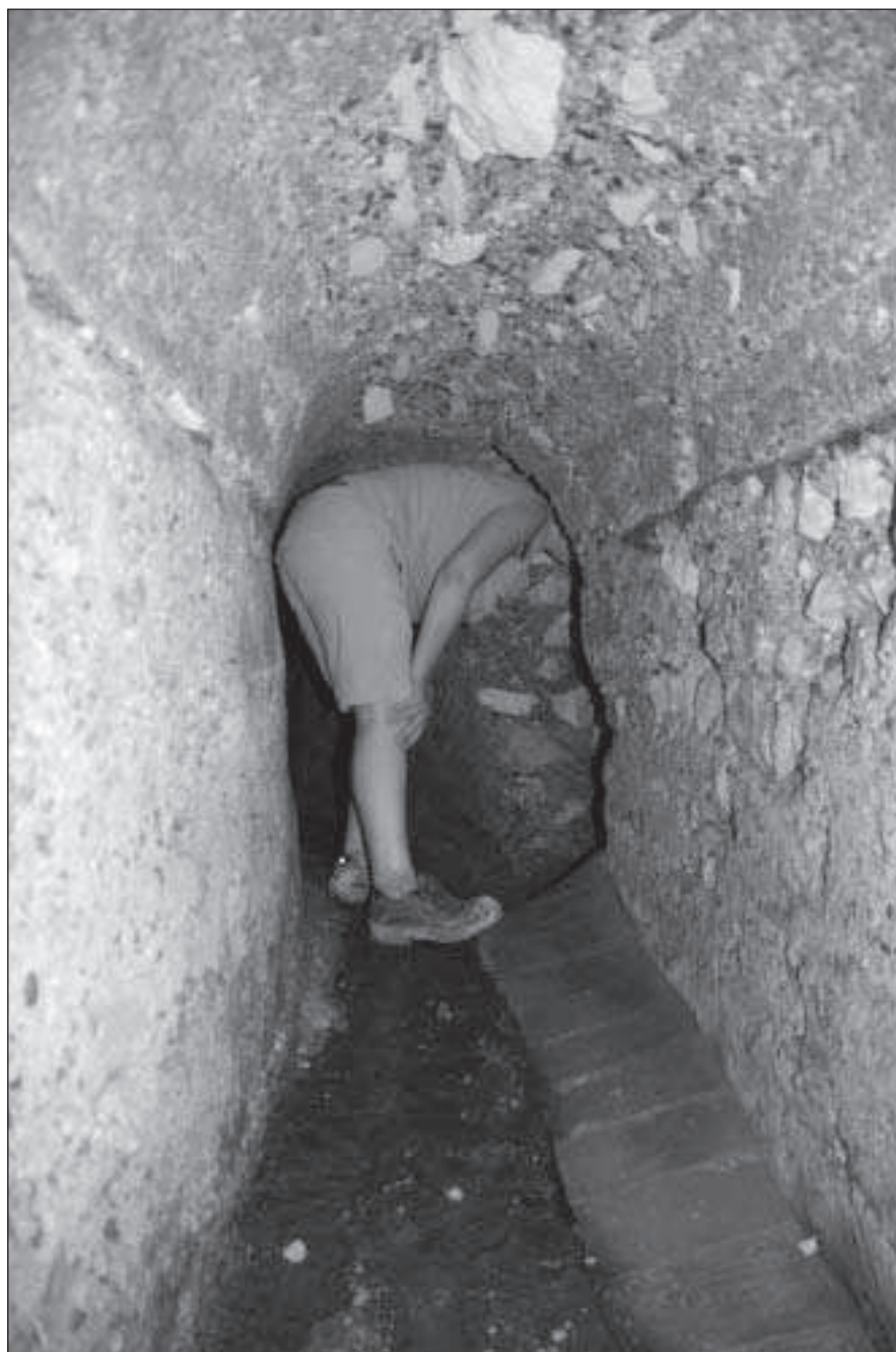
Figura 6. Vista de l'interior de la conducció romana en la nau lateral de la catedral
