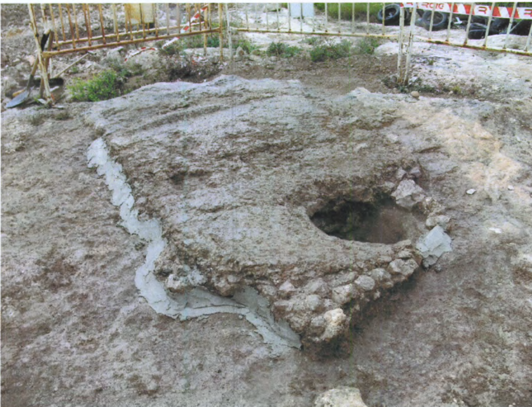
Figura 27. Vista general del paviment. Pot observar-se la consolidació de les vores de l'estructura
