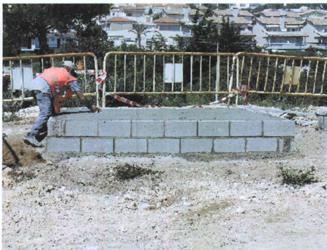
Figura 31 . Vista frontal del calaix un cop disposada la capa de formigó.
