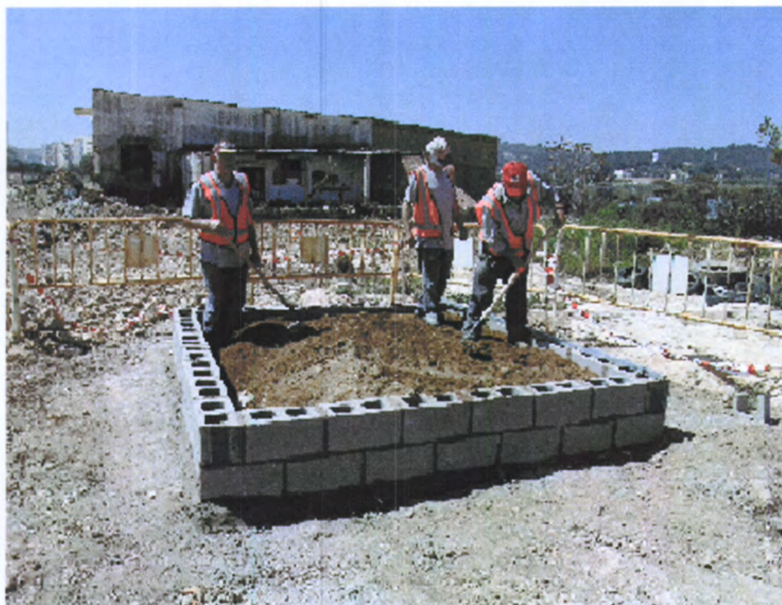
Figura 30 . Vista general del cobriment i premsat de terra del paviment
