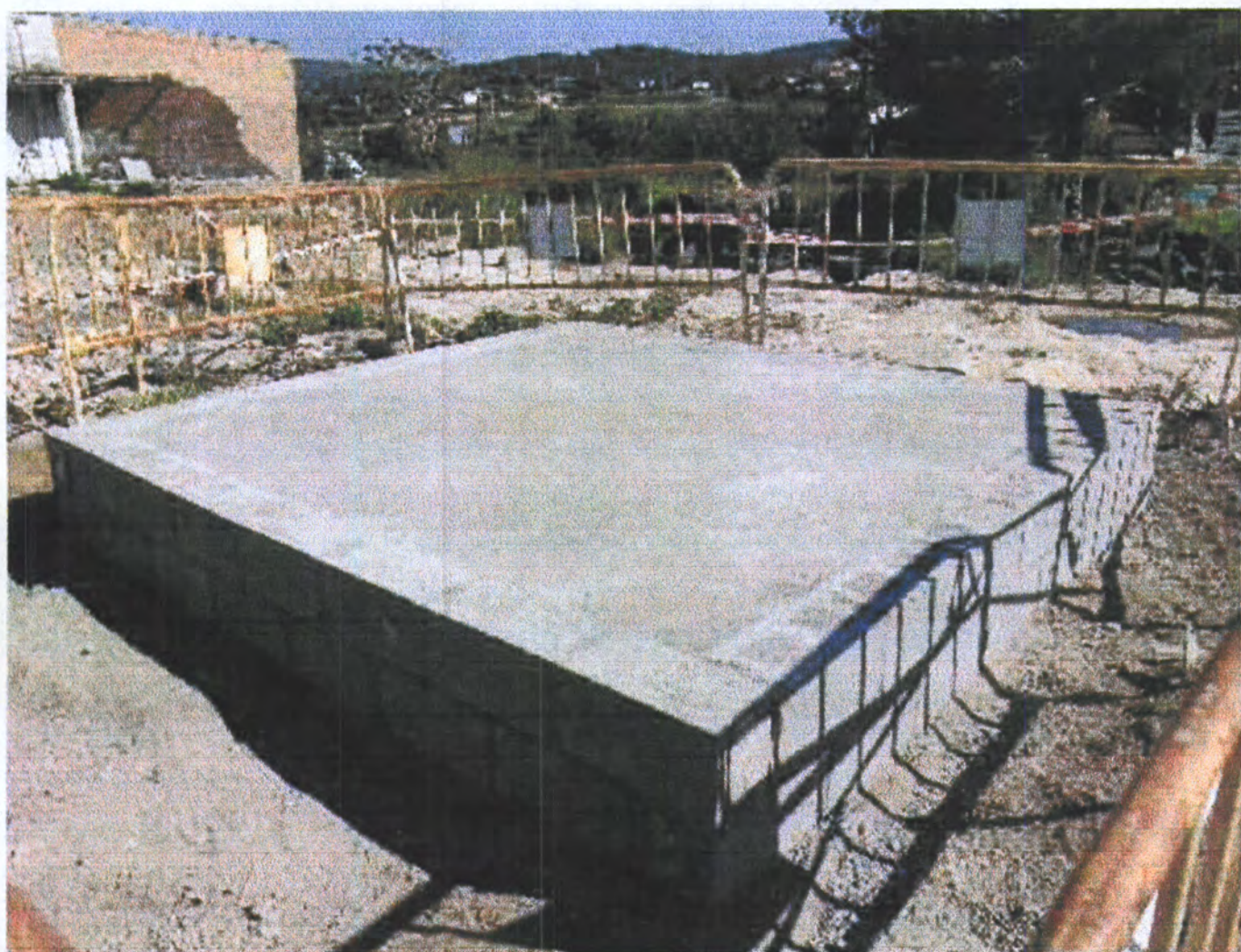
Figura 32 Vista general del resultat de la construcció del col·loc de protecció i aïllament del paviment.
