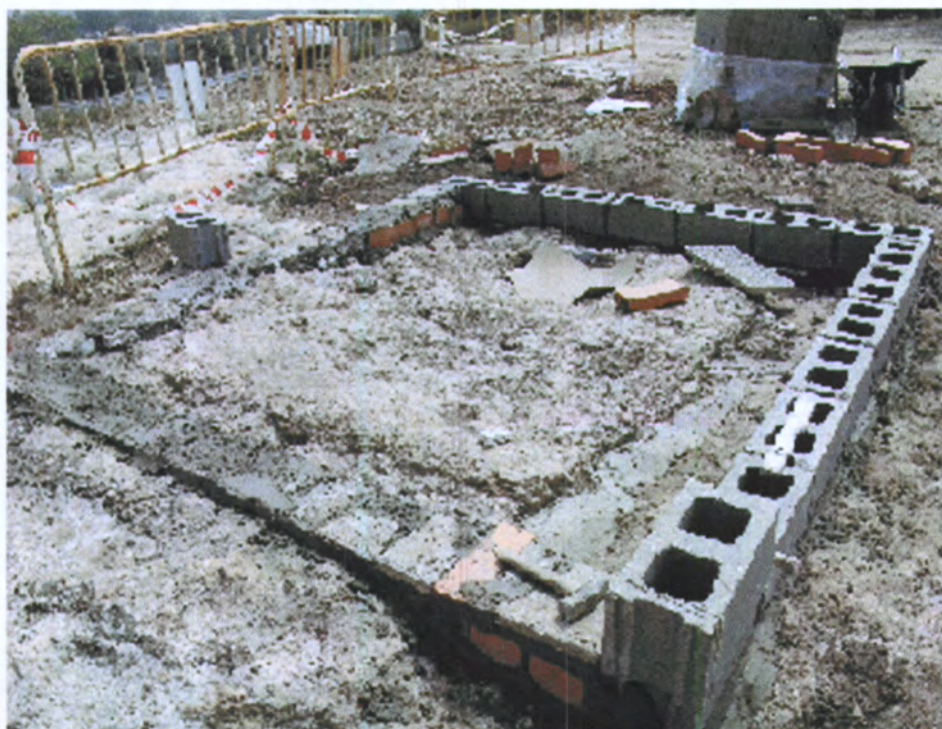
Figura 28. Procès de construcció del muret perimetral de protecció del lacus
