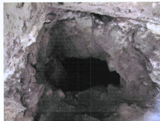
5. Forat obert a la volta del Ganganell a la sala de recepció.
