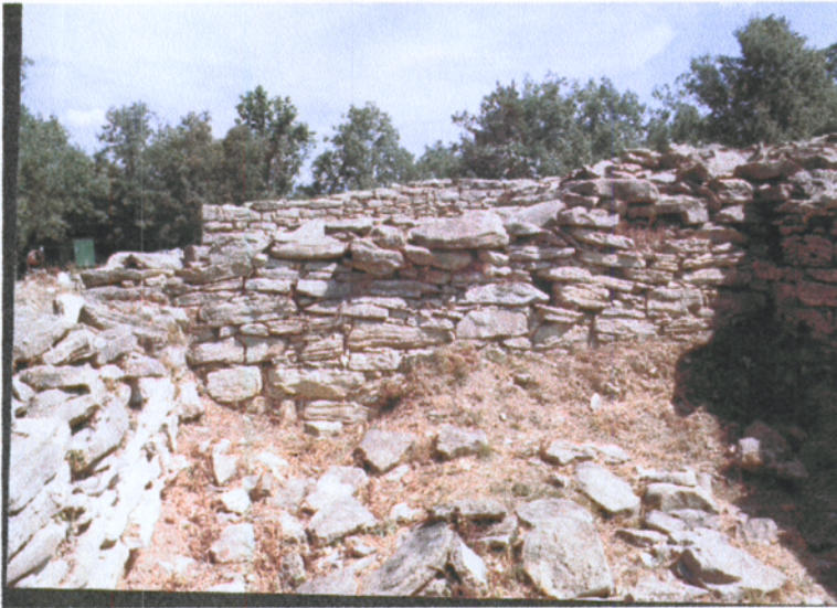
Fig. 7: Cara sud del mur 4 abans de la consolidació.
