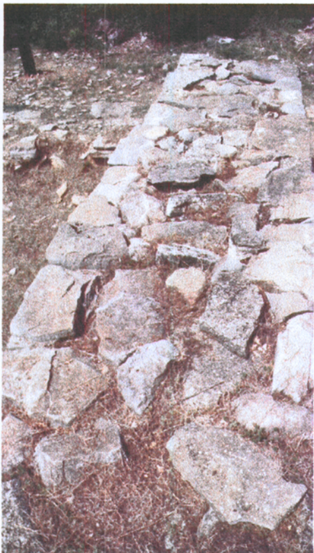
Fig. 5: Mur 3. Filada superiors abans de l'actuació.
