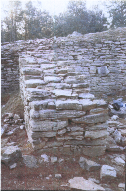
Fig. 10: Vista del mur 5 després de la consolidació.
