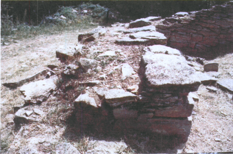
Fig.1: Mur 1. Abans de la consolidació.
