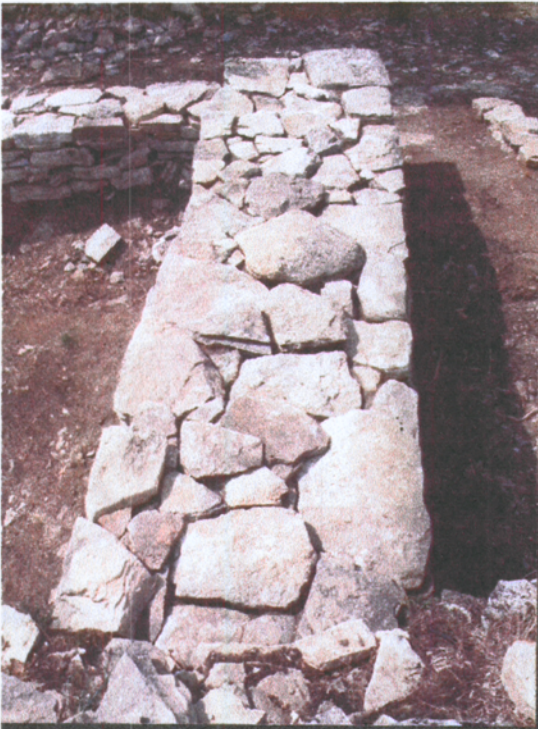
Fig. 8: Part superior del mur 4 després de la consolidació.
