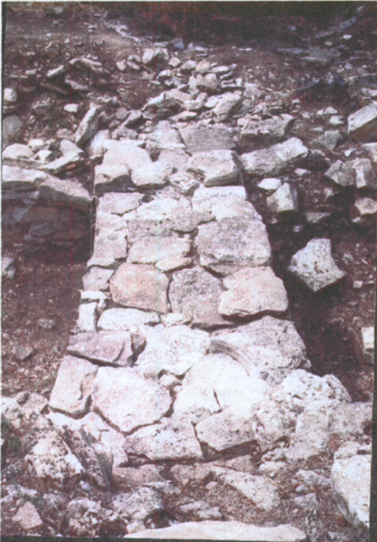
Fig. 18: Filada superior del mur 9 després de la consolidació.
