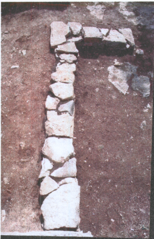
Fig. 22: Mur de tancament de l'àmbit 3 després de la consolidació.
