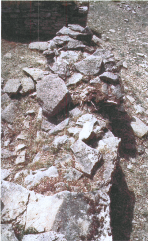
Fig. 23: Mur de tancament de l'habitació 4. Abans de l'actuació.
