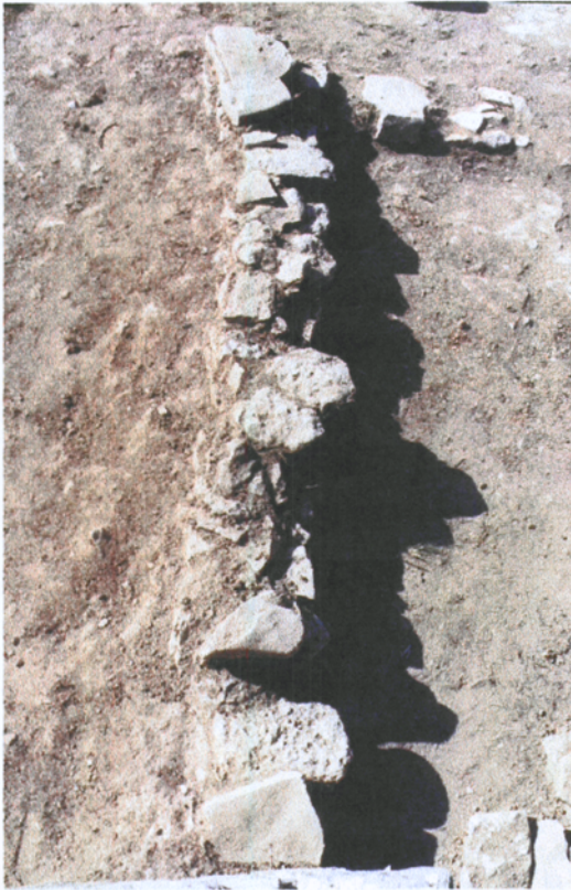
Fig. 21: Mur de tancament de l'àmbit 3, abans de la consolidació.
