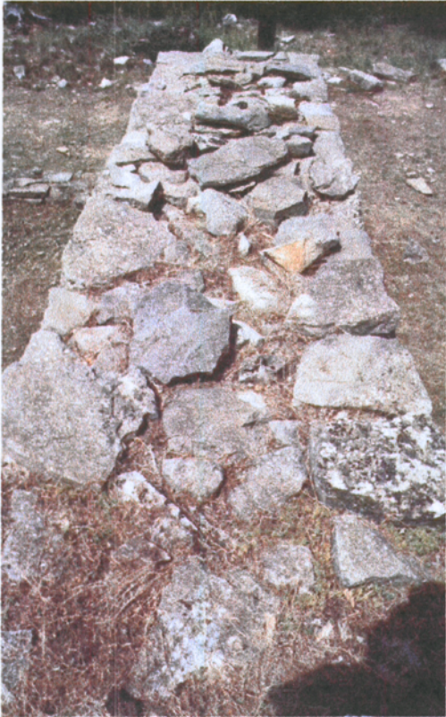
Fig. 3: Mur 2 abans de la consolidació. Filada superior.
