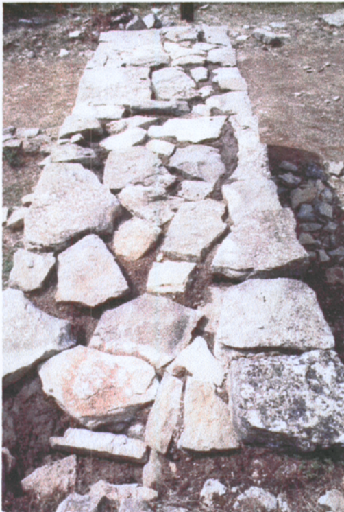
Fig 4: Mur 2 consolidat. Vista de la filada superior.
