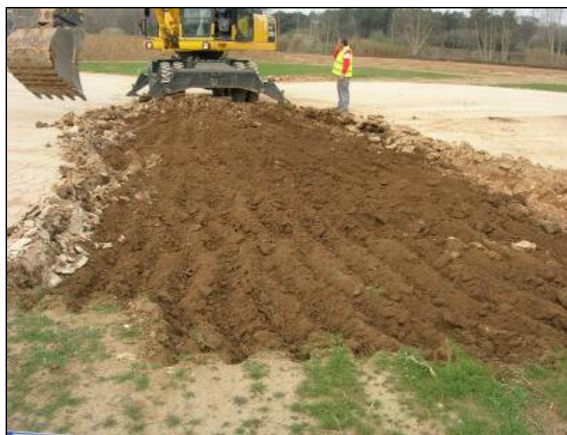
38. Màquina realitzant el rebaix al Tram1B .
