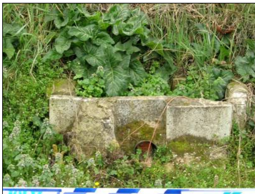
25. Detall de la fillola en el tram del canal obrat amb plaques de ciment.
