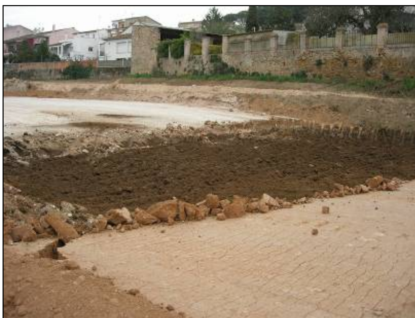
32. Espai del vial entre parcel·les rebaixat ( Tram 1A).
