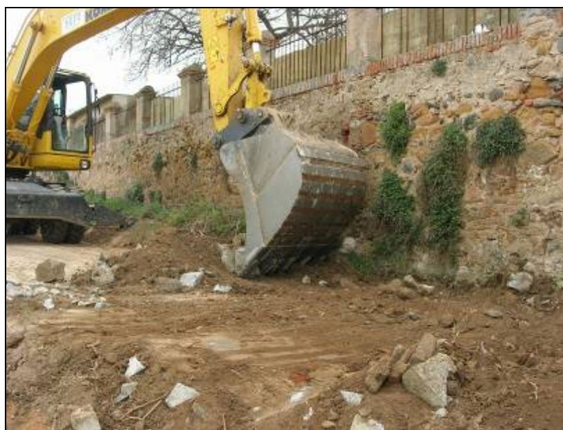
56. Inici del rebaix del canal arran del mur de tanca.
