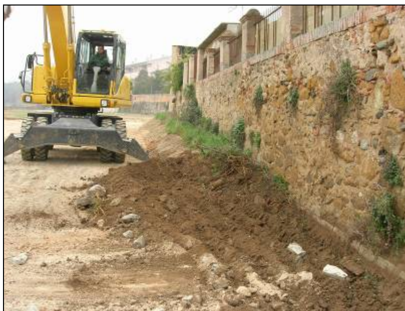
57. Rebaixos arran del mur de tanca.
