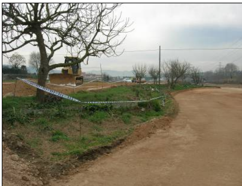
21. Tram del canal obrat amb plaques de ciment.
