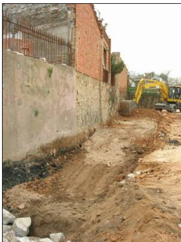
68. Rebaixos arran del mur de tanca.
