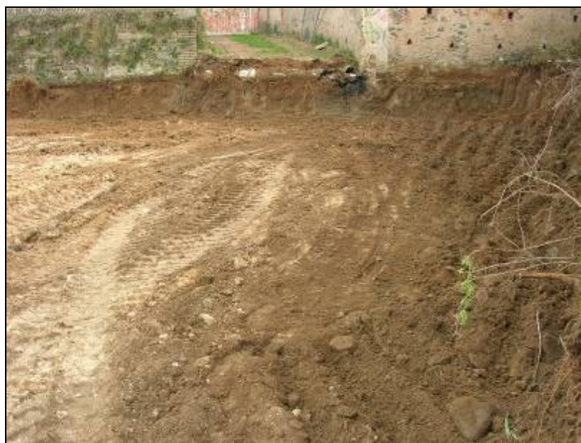
61. Rebaixos arran del mur de tanca finalitzats.
