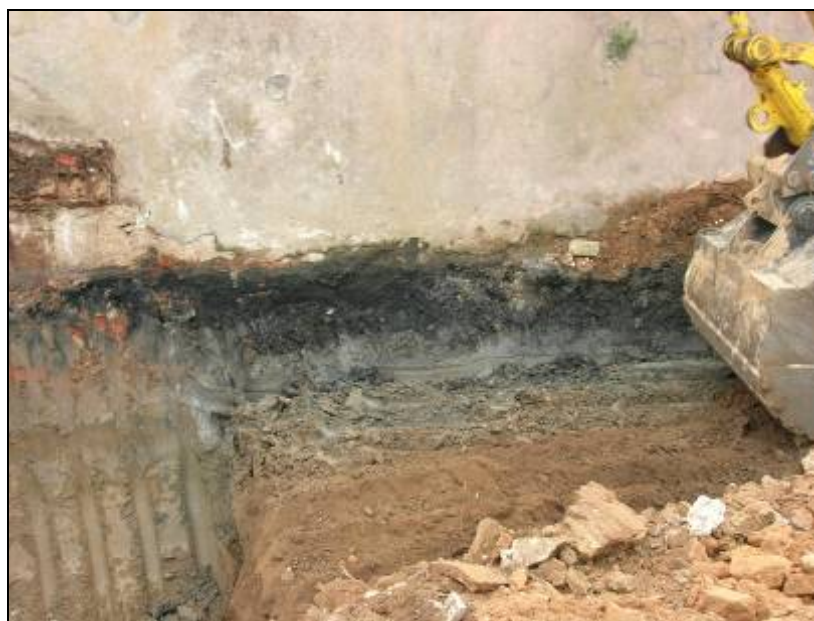
65. Rebaixos arran del mur de tanca.
