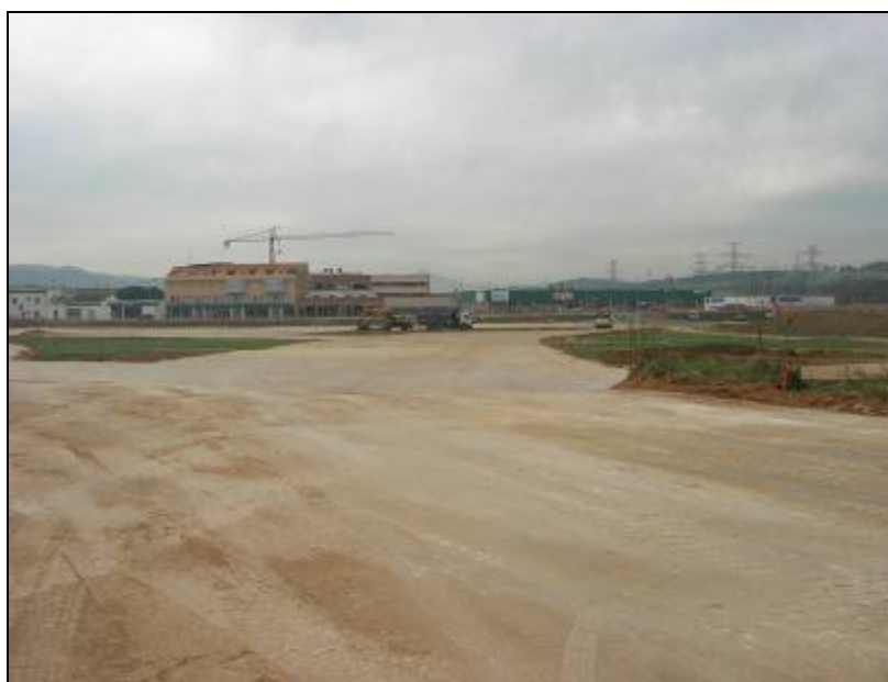
2. Vista general del sector SPR4.
