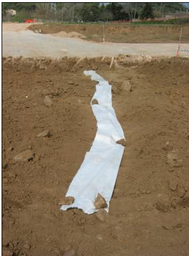
46. Cobriment amb geotèxtil del mur UE 100.
