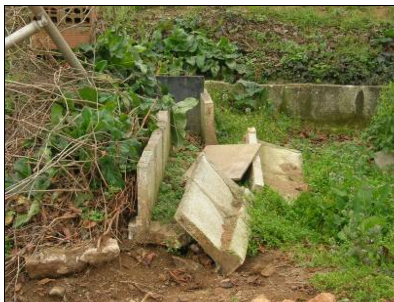
24. Detall del tram del canal obrat amb plaques de ciment.
