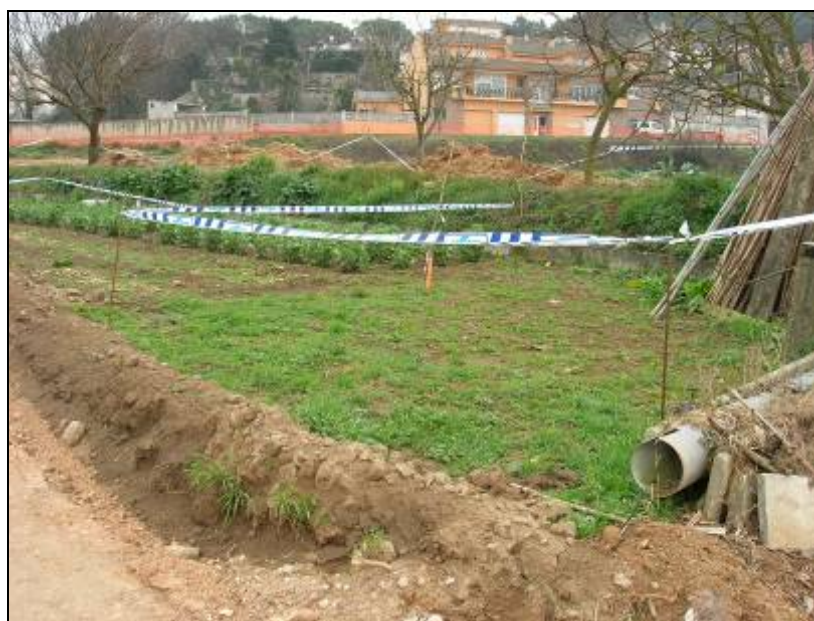
26. Vista general del tram del canal obrat amb plaques de ciment.
