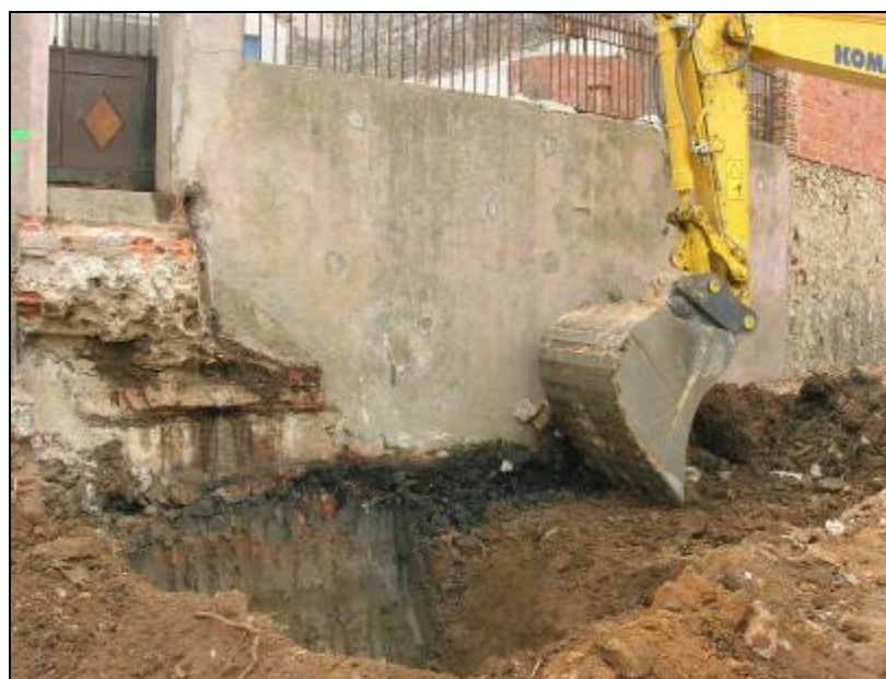
64. Rebaixos arran del mur de tanca.
