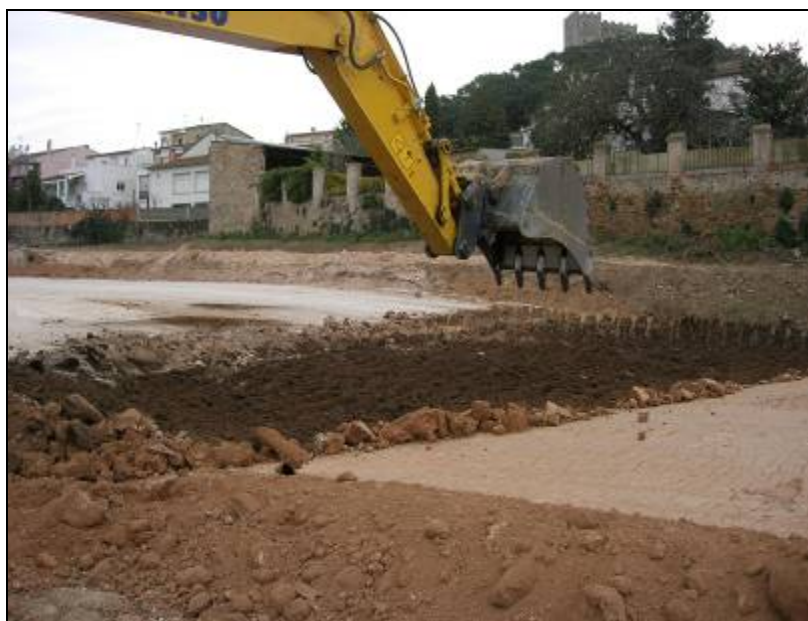
31. Màquina rebaixant el terreny.
