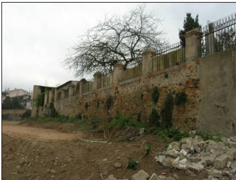
8. Mur de tanca. Vista general.
