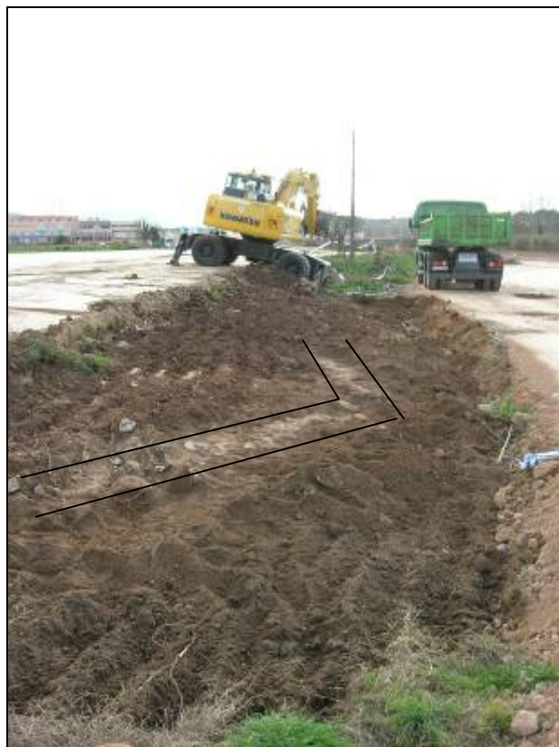
53. Tram3. S'aprecia el mur seguint la línia del canal existent.
