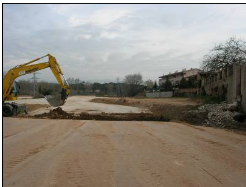
30. Màquina rebaixant el terreny.
