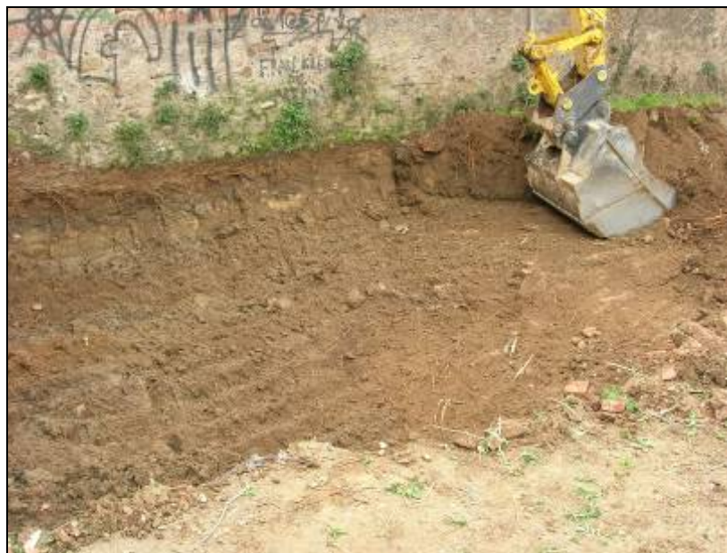
59. Rebaixos arran del mur de tanca.
