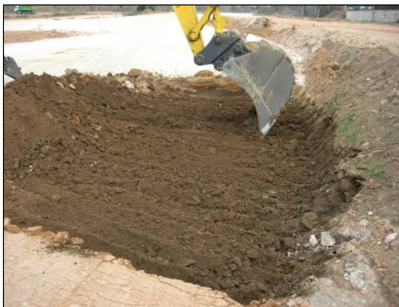
29. Màquina rebaixant el terreny.
