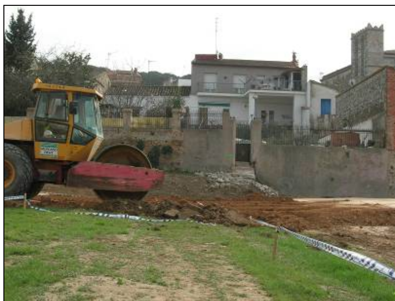
36. Compactació del terreny.
