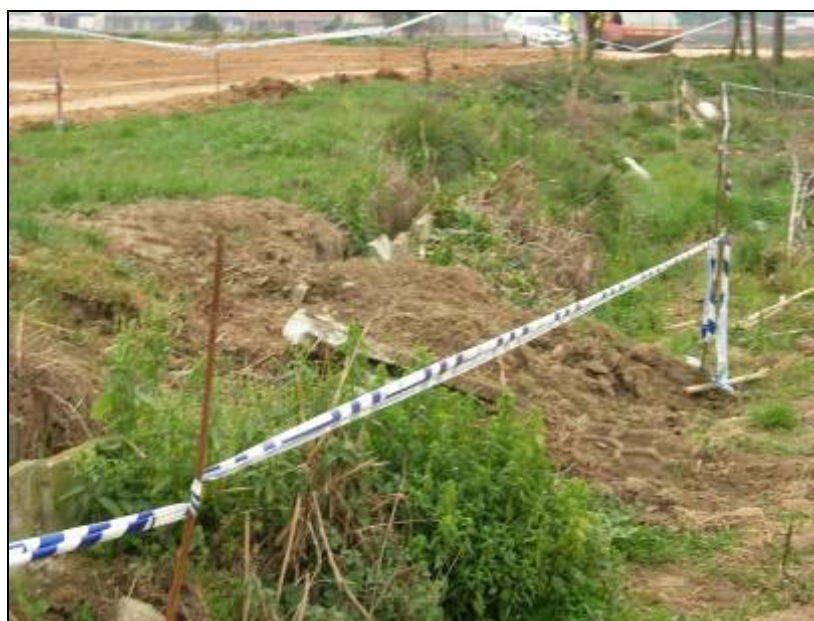
20. Tram del canal obrat amb plaques de ciment
