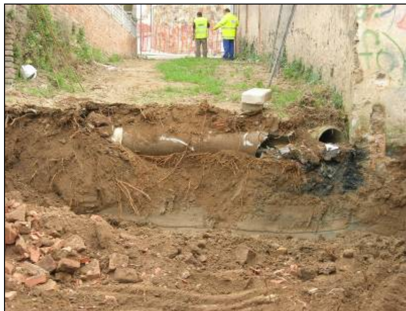
60. Rebaixos arran del mur de tanca. S'observen les restes del canal.
