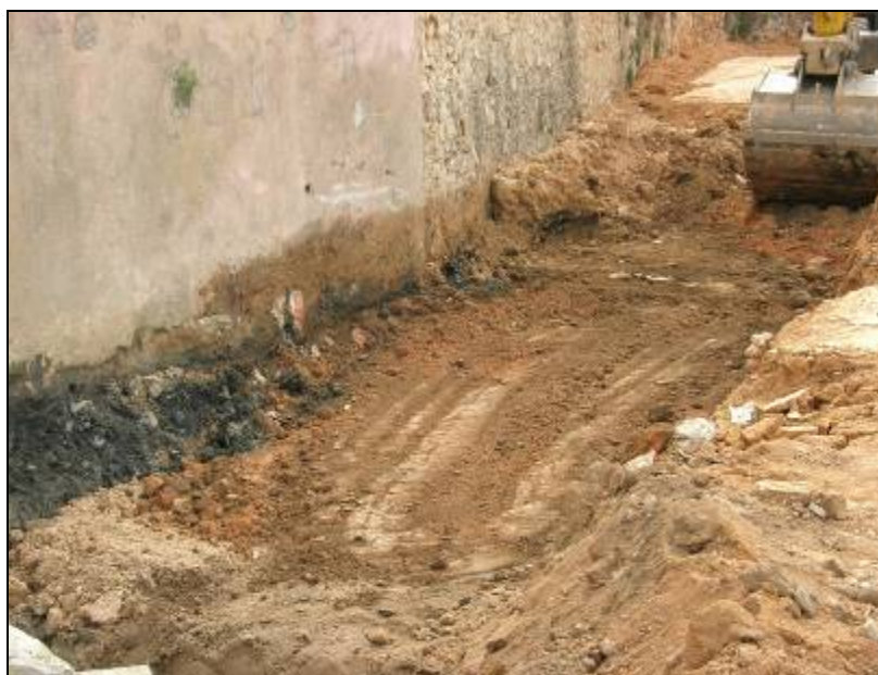
67. Rebaixos arran del mur de tanca.
