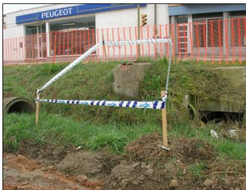
4. Vista dels diversos espais de desguàs.
