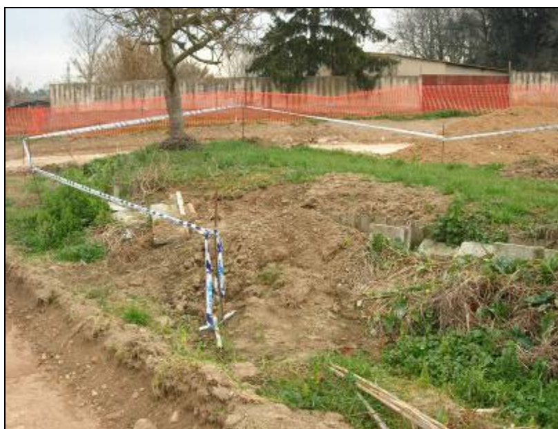
22. Tram del canal obrat amb plaques de ciment.
