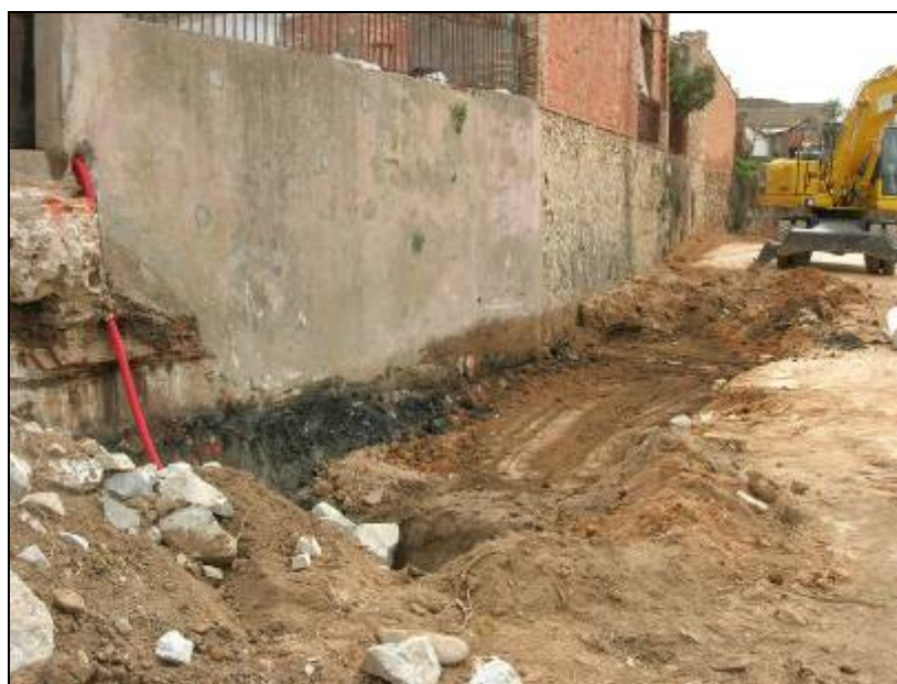
66. Rebaixos arran del mur de tanca.
