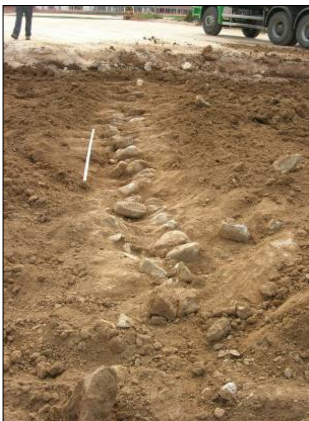
45. Vista general del mur.
