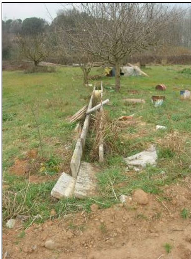
27. Tram del canal obrat amb plaques de ciment.
