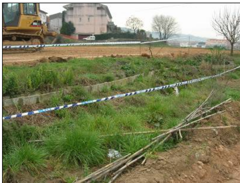
23. Tram del canal obrat amb plaques de ciment.
