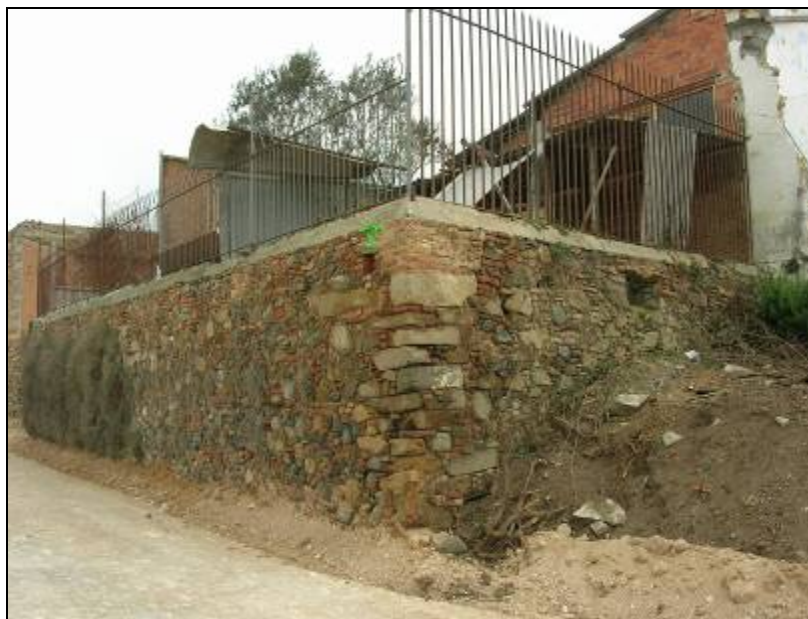
5. Mur de tanca dels edificis del carrer Major per on passa el rec.
