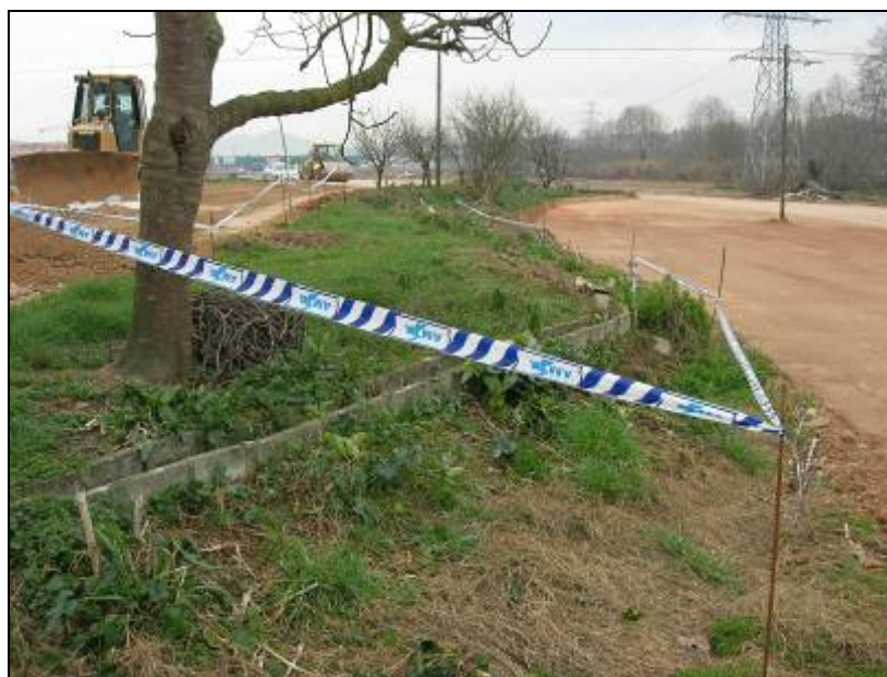
19. Tram del canal obrat amb plaques de ciment.
