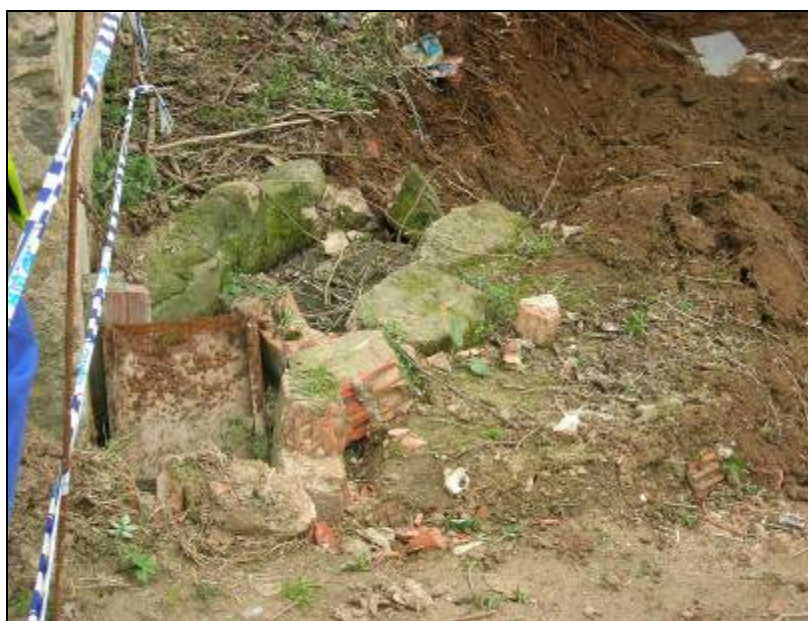
58. Rebaixos arran del mur de tanca. S'observen les restes del canal.
