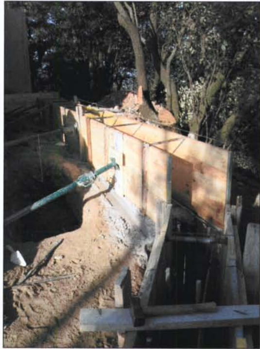
Reompliment amb el formigó armat
