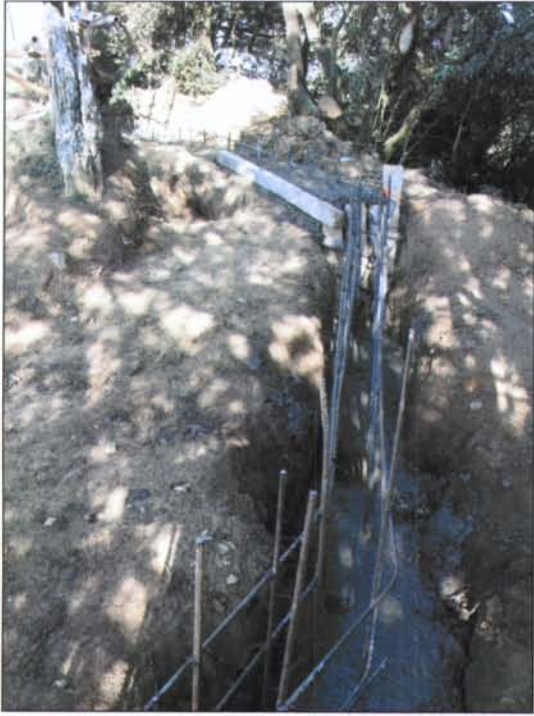
Reompliment amb el formigó armat
