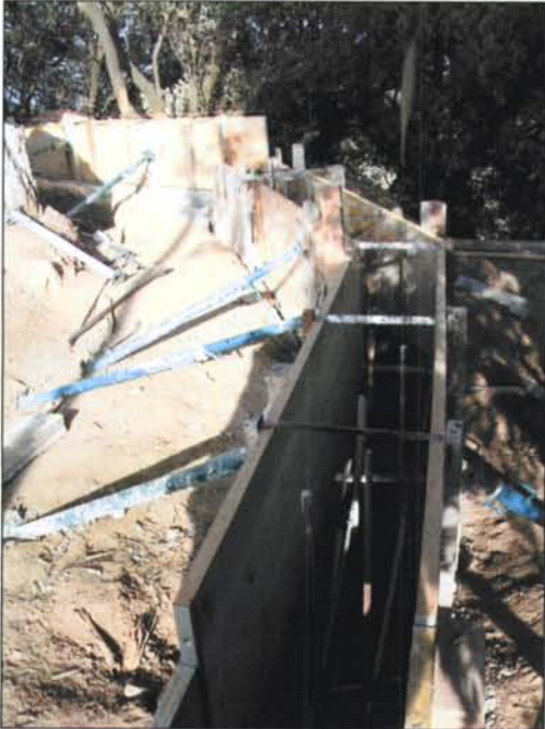
Encofrat per elevar els murs
