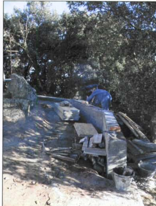
Encofrat per elevar els murs
