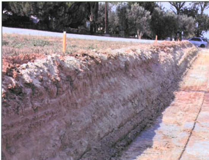
Vista del tall resultant un cop efectuats els rebaixos.
