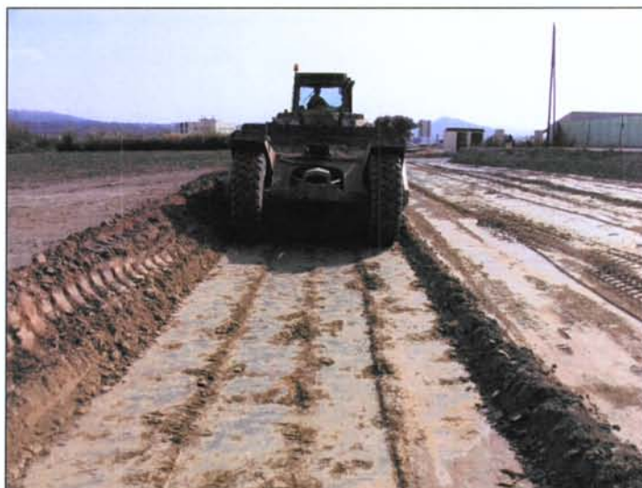
Obertura del carrer. Rebaixos de terres amb maquinària.
