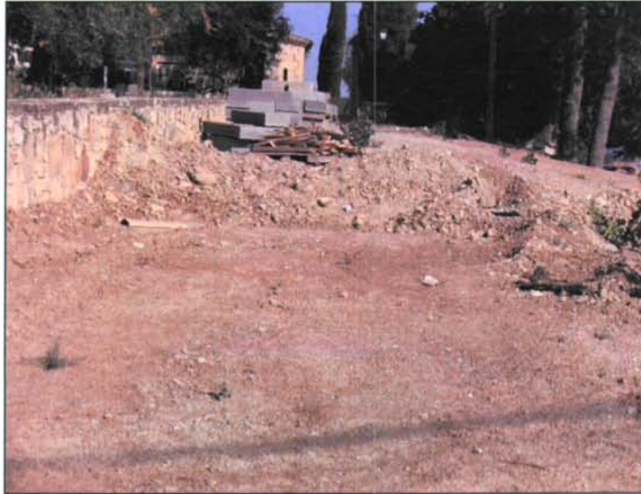
Sector B. Vista parcial
