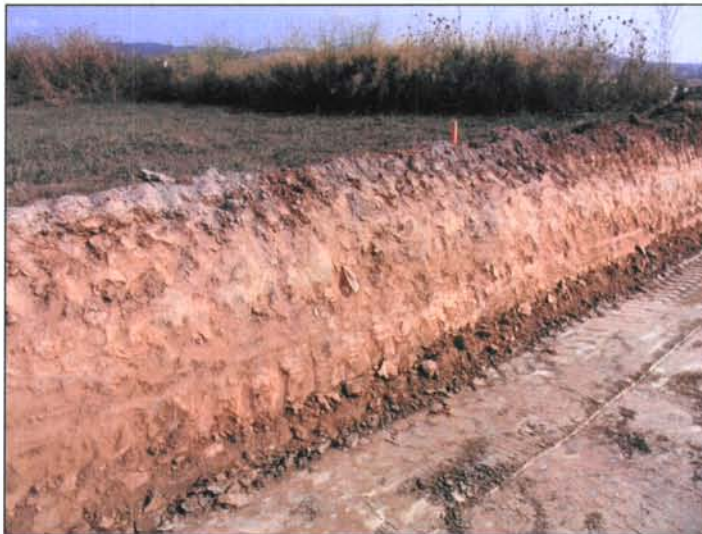
Vista Est del tall resultant un cop efectuats els rebaixos.
