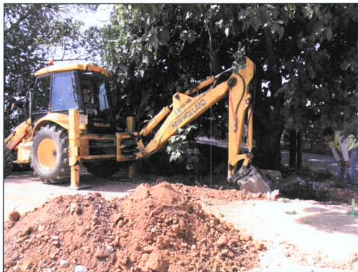
Sector B. Realització de la rasa amb mitjans mecànics
