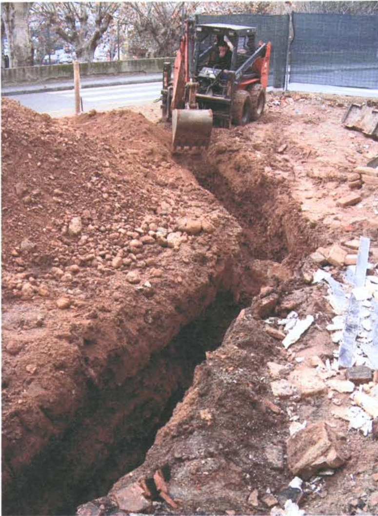
Imagen 2. Cambio en la orientación N-S de la zanja inicial de sondeo.
