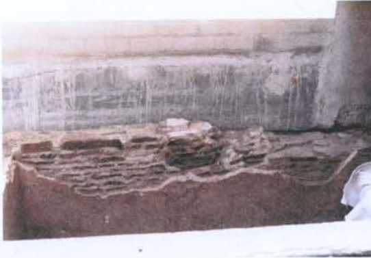
Reintegració del mur amb fragments de tègula i ceràmica. Dipòsit B
