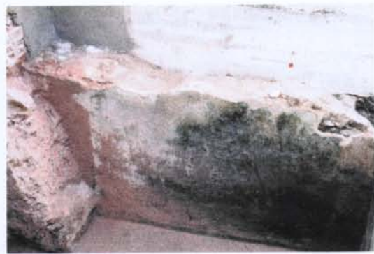
Procés d'eliminació del mur de terradipòsit B
