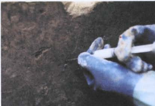
Injecció de consolidant a les esquerdes
