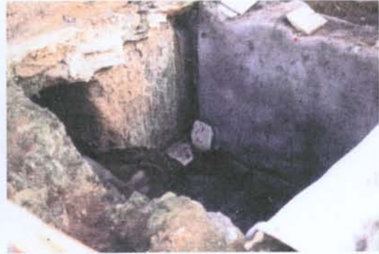
Un cop eliminada la vegetació i abans de l'extracció del geotèxtil
