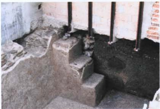
Després de reforçar l'edifici, es continua la excavació fins on és possible
