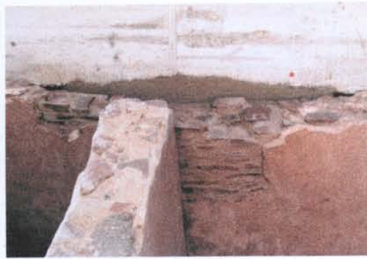
Reintegració del mur a l'altre extrem
