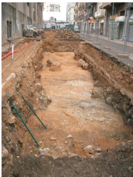
FOTO 3: Fotografia general de la zona excavada del Carrer Reding. Podem veure part de la xarxa de serveis localitzada.
