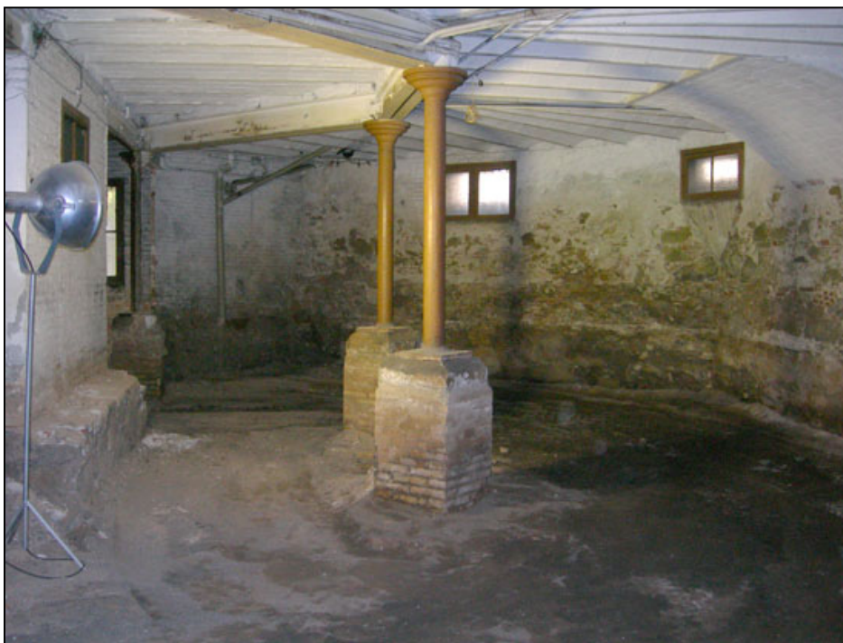
Imatge del soterrani un cop realitzat el rebaix general
