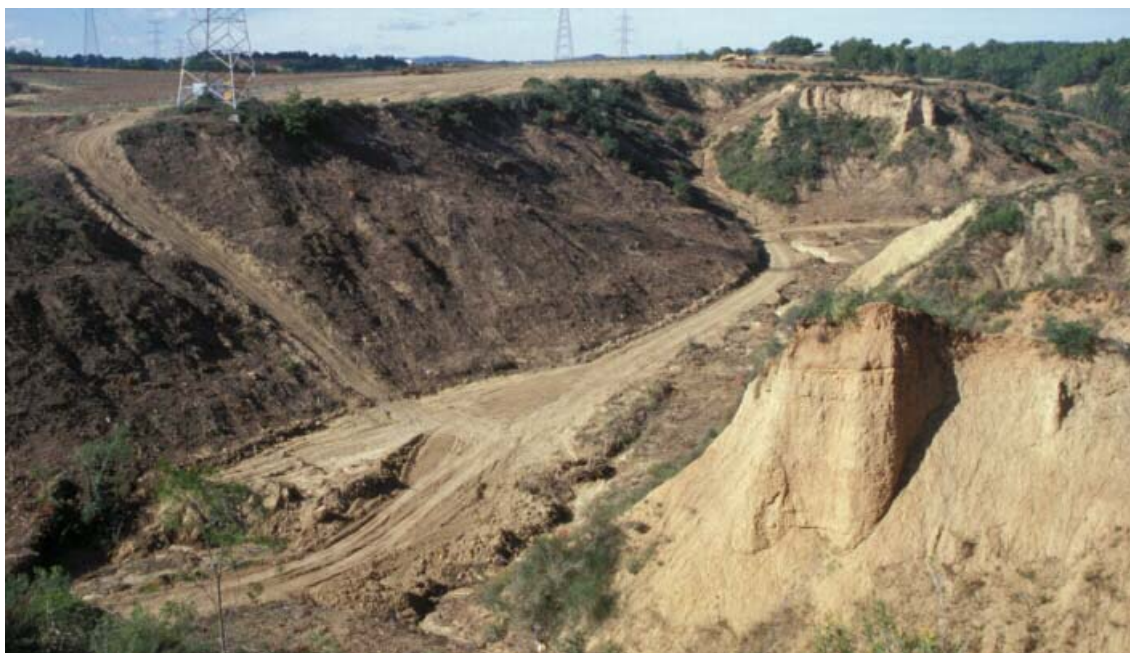
Figura B1. Panoràmica de la zona d'afectació de les obres corresponent a la C1, després d'eliminar la cobertura vegetal.
