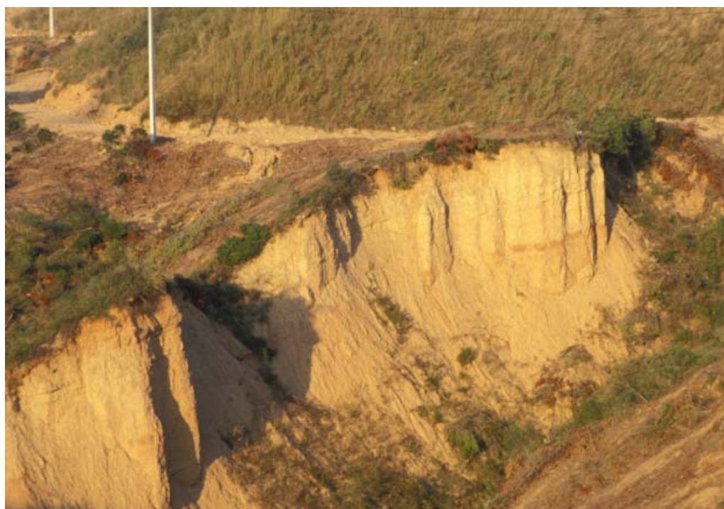
Figura C5. Aspecte del PP6 després de la desforestació.
