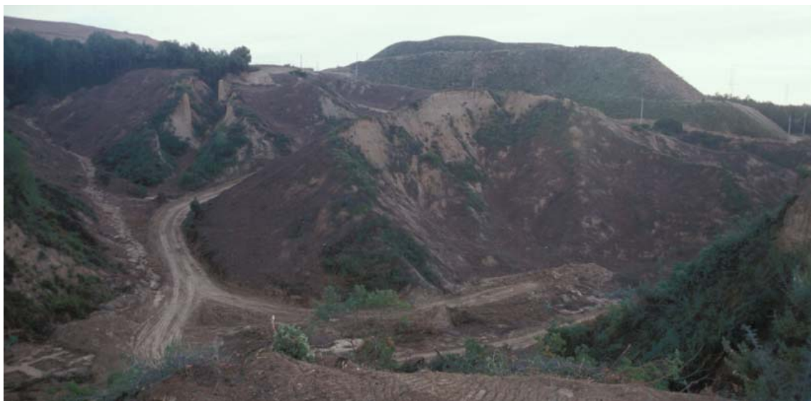
Figura B2. Panoràmica de la zona d'afectació de les obres corresponent a la C1, després d'eliminar la cobertura vegetal.
