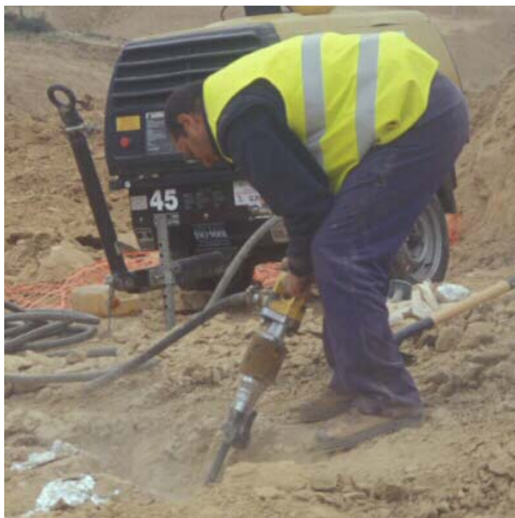
Figura B20. Peó utilitzant un martell pneumàtic en la zona de la BDAd.
