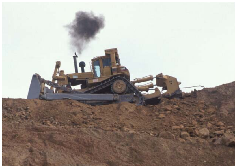
Figura B11. Bulldozer llaurant el terreny.
