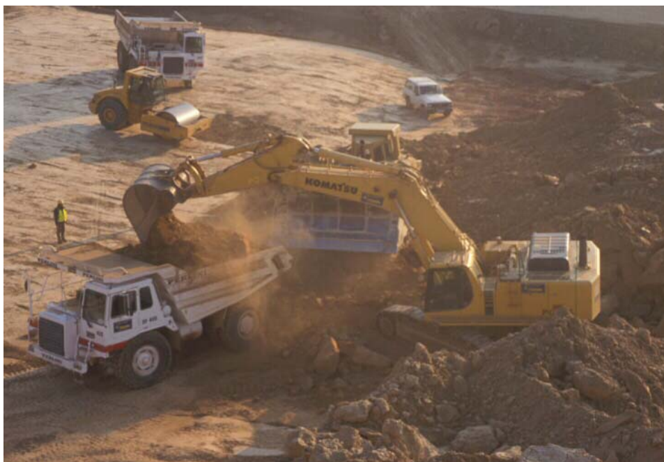
Figura B6. Giratòria Komatsu 600 realitzant tasques d'excavació.
