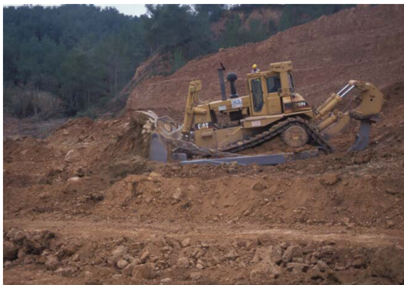
Figura B10. Bulldozer empenyent la terra llaurada.
