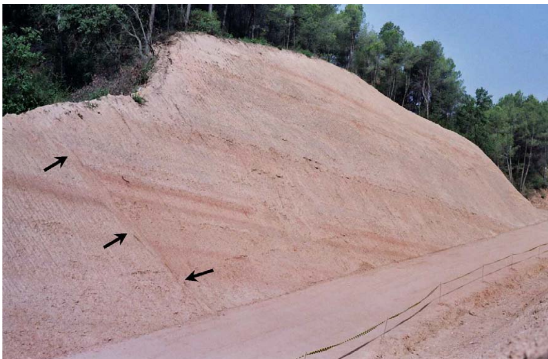
Figura D1. Falla B, detectada al VIE-B. Les fletxes indiquen el pla de falla. Al terç superior de la fotografia s'observen uns conglomerats de gruix mètric i entitat cartogràfica, que malgrat que no s'aprecii bé a la fotografia, es troben constituïts per una amalgama de nivells conglomeràtics, de gruix proper al metre amb les bases i els sostres de morfologia lenticular, que passen lateralment a gresos i llims de manera molt ràpida.
