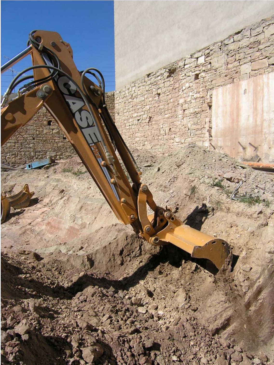
5. Detall del rebaix mecànic en la seva fase final.
