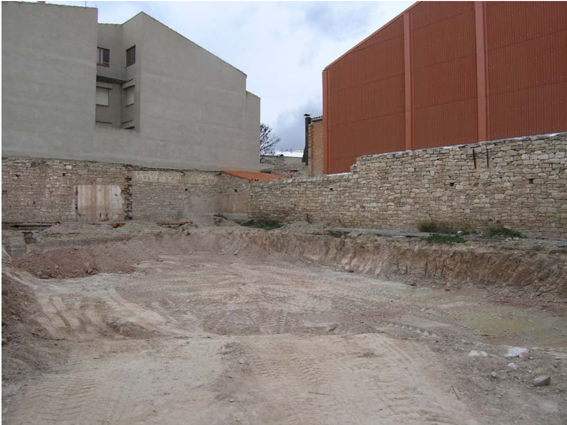
7. El solar una vegada acabat el rebaix.
