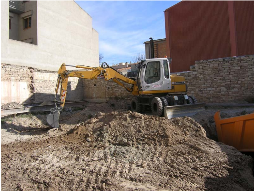
3. El procés de rebaix mecànic de la capa més superficial.
