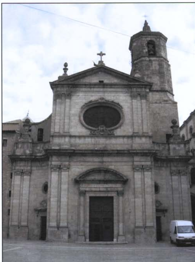
Foto 16: Vista des de l'oest de parròquia de la Mercè
