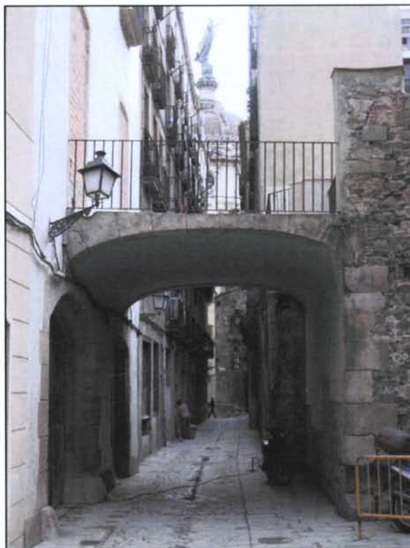
Foto 2. Vista des del nord-oest d'un dels ponts situat al carrer Carabassa
