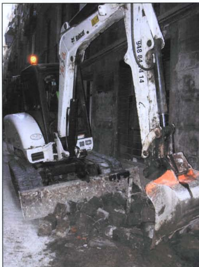
Foto 6: Procés d'aixecament de les llambordes amb la retro-excavadora
