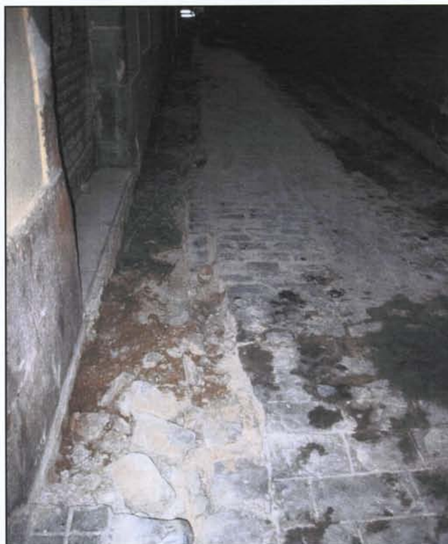
Foto 14: Procés d'obertura de la rasa (R-3) al carrer Còdols
