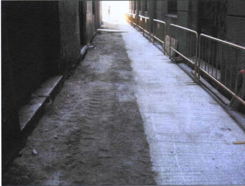
Foto 11: Vista des del nord est del carrer Còdols abans de col·locar el nou paviment
