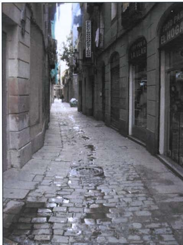
Foto 1. Vista des del sud-est del carrer Serra abans de començar la intervenció
