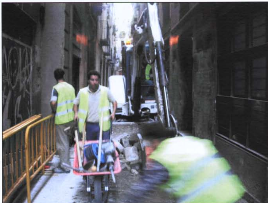
Foto 9: Imatge presa durant les tasques d'adequació del carrer Serra
