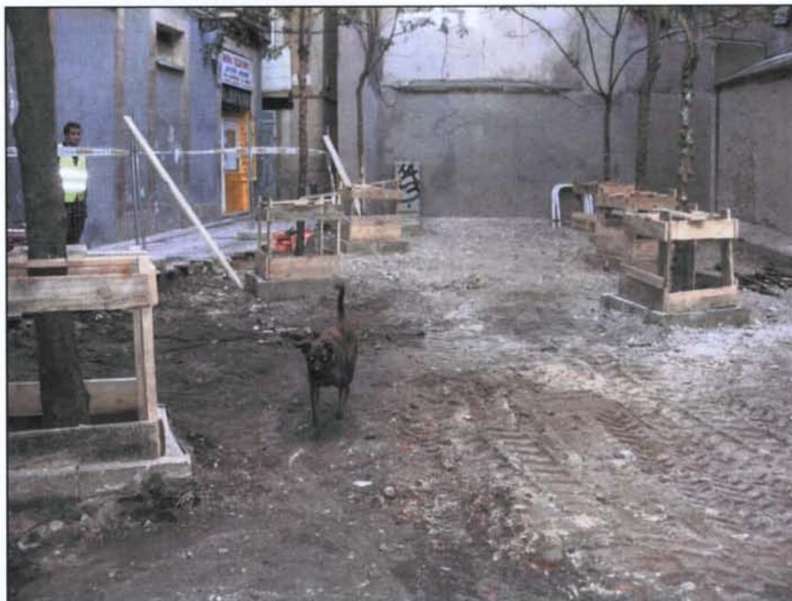
Foto 5: Vista des del nord-est de l'espai situat en l'encreuament del carrer Rosa amb el carrer Carabassa després de l'aixecament del ferm
