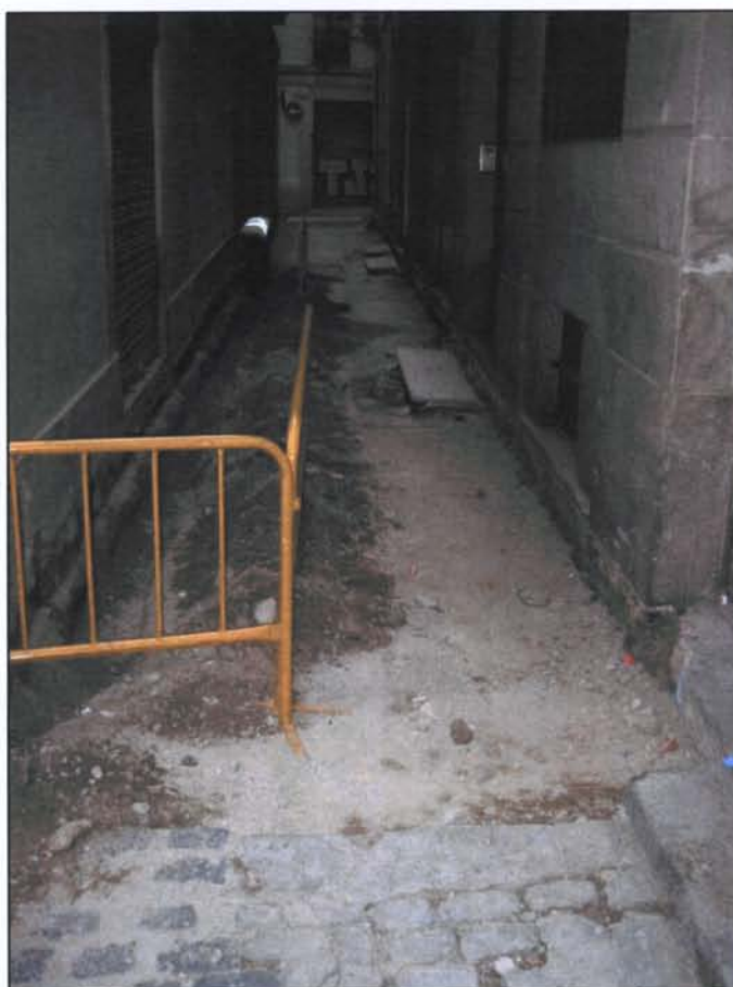
Foto 10: Vista des de l'est del carrer Rosa amb la rasa (R-2) feta per canviar el cablatge de l'enllumenat públic
