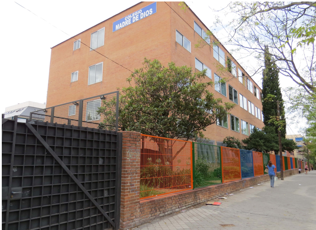
Colegio Madre de Dios, construido en el solar donde se erigieron las galerías en Madrid.
