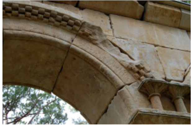
Carreus i dovelles afectats per ruptures semi circulars en les vores i cantonades.
