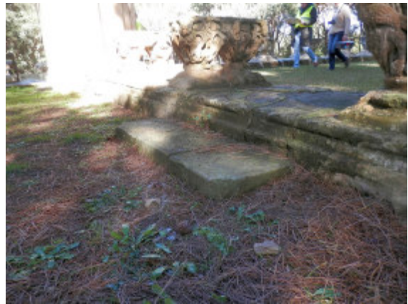
Tram de cornisa (esquerra) i tres carreus (dreta) aprofitats com a esglaons d'accés a l'interior del claustre.
