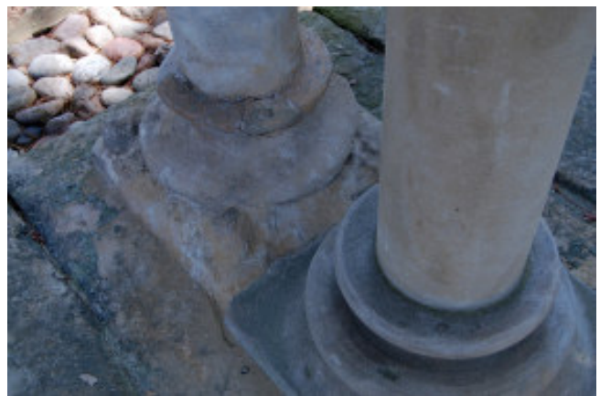
Base de columna substituïda, amb un disseny més senzill que les originals.
