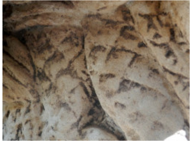
Restes d'activitat biològica del que semblen colònies de fongs o líquens tractats per un biocida de Cu i probablement erosionats per un tractament mecànic.
