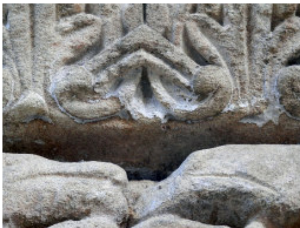
Restes de líquens que devien formar un biofilm més o menys continu, parcialment eliminades en algun tractament mecànic i morts per l'aplicació d'un biocida en base a Cu.
