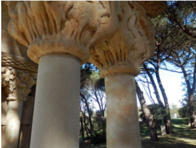
A l'esquerra de la fotografia es veu un fust nou (fabricat amb torn mecànic) mentre el de la dreta és un fust de pedra de Villamayor en bon estat de conservació.
