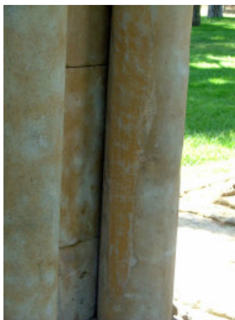
Reparació d'una dovella fissurada.
