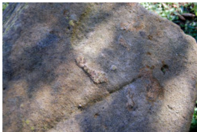
Restes de morter de calç a la superfície de la dovella.
