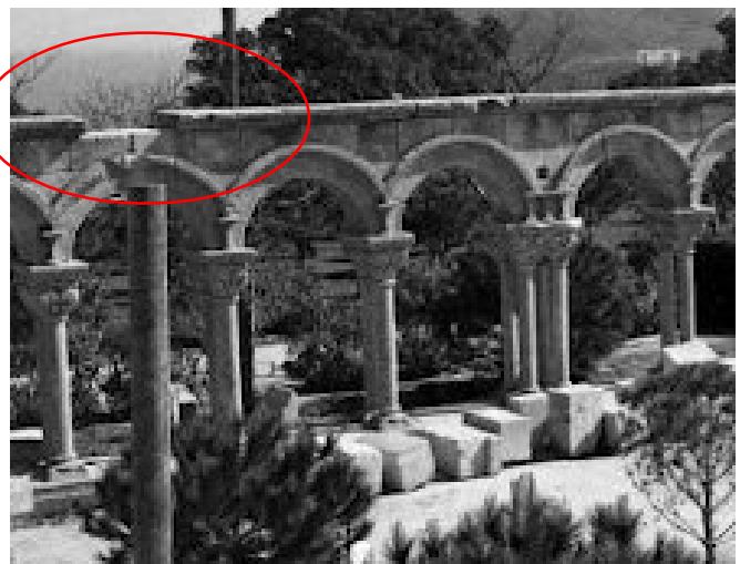
Fotografia de les arcades de l'ala Est on faltava un tram de cornisa; s'ha deixat el buit en el moment del muntatge segurament amb la voluntat de seguir i respectar la numeració realitzada en Ciutat Lineal i posteriorment s'ha completat amb peces sobrants de l'ala no muntada.
