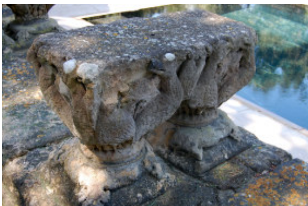
Parella de capitells muntats sobre l'ampit del claustre: la seva exposició en superfície horitzontal facilita la colonització d'aquesta de forma molt més intensa que zones amb altra geometria, com el propi capitell.
