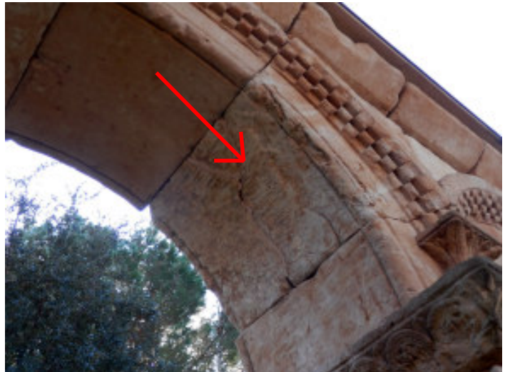
Reparació d'una dovella fissurada.
