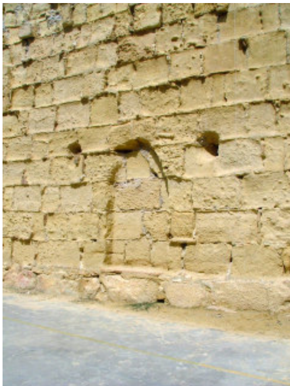
Un exemple de preconsolidació es troba molt clarament a la muralla de Tarragona: els carreus de la fàbrica han perdut secció degut als cicles de mullat-assecat de les argiles de la matriu però en les vores s'observa que hi ha 1-2 centímetre molt ben conservats. Això és el resultat de la preconsolidació: en l'espessor de pedra on ha penetrat la calç s'ha mantingut la seva cohesió.
