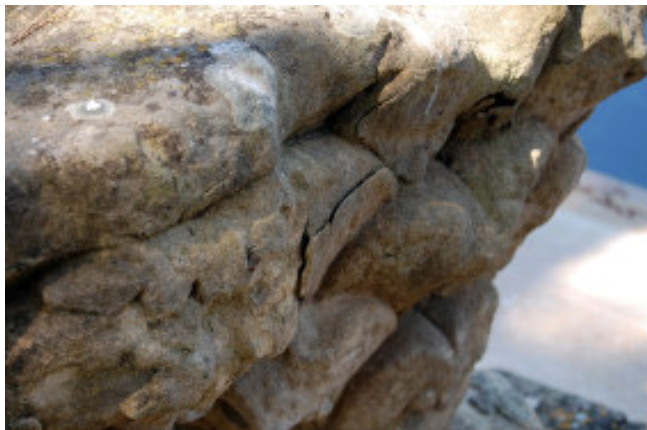
Detall d'un capitell de la filera oest que s'està esquerdant i desprenent-se la part superior del relleu escultòric.
