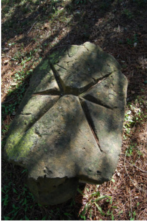
Dovella fora de context on es pot observar la presència dels canalons de distribució de la calç en la superfície de contacte amb les peces veïnes.
