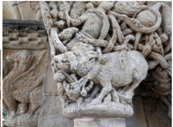
Noteu les marques d'erosió dels collarins de sengles capitell.
