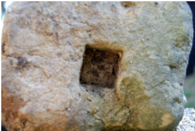
Ubicació del morter de calç a l'interior del fragment de fust.
