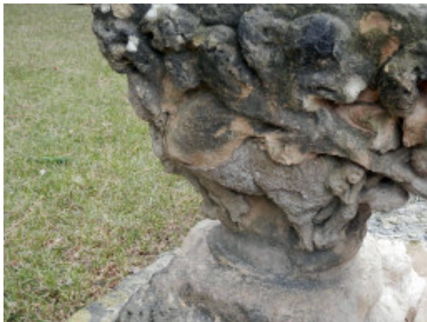
Capitell de l'ala Oest on s'ha després una zona de la pedra. Es pot observar que s'ha tornat a formar un biofilm en la zona de ruptura fresca.
