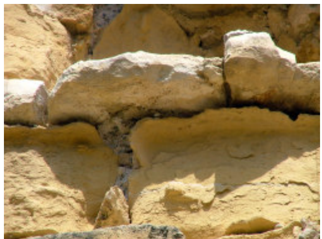
Un exemple de preconsolidació es troba molt clarament a la muralla de Tarragona: els carreus de la fàbrica han perdut secció degut als cicles de mullat-assecat de les argiles de la matriu però en les vores s'observa que hi ha 1-2 centímetre molt ben conservats. Això és el resultat de la preconsolidació: en l'espessor de pedra on ha penetrat la calç s'ha mantingut la seva cohesió.
