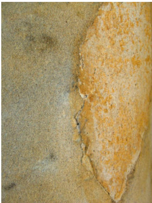
El morter hidràulic (de color rosat) està per sobre del morter bastard, de color blanc
