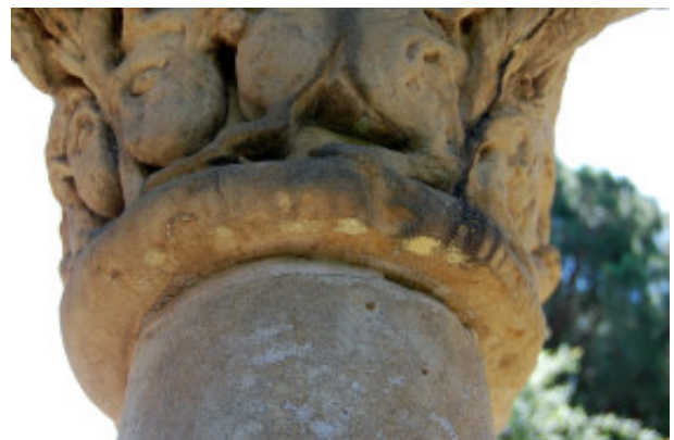
Junta entre fust i capítell executada amb morter ràpid.
