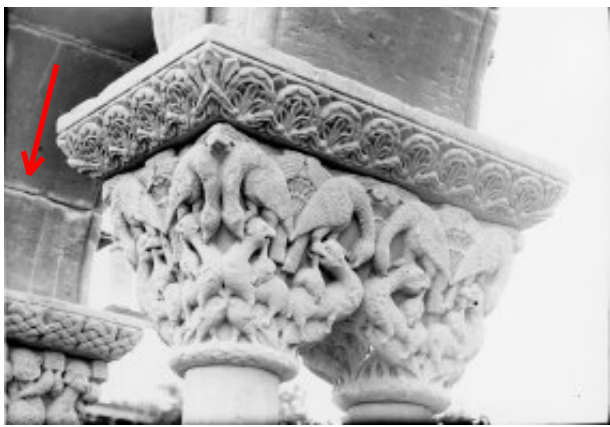
El claustre a Ciudad lineal, 1931-33: Noteu que les juntes entre dovelles han estat obertes i el color més clar de la zona erosionada degut a la pèrdua de la part exterior de pedra acolorida per l'oxidació dels hidròxids de ferro. Fotos IPCE
