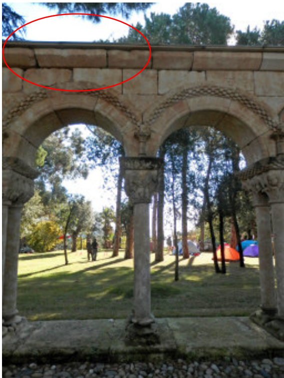
Fotografia de les arcades de l'ala Est on faltava un tram de cornisa; s'ha deixat el buit en el moment del muntatge segurament amb la voluntat de seguir i respectar la numeració realitzada en Ciutat Lineal i posteriorment s'ha completat amb peces sobrants de l'ala no muntada.
