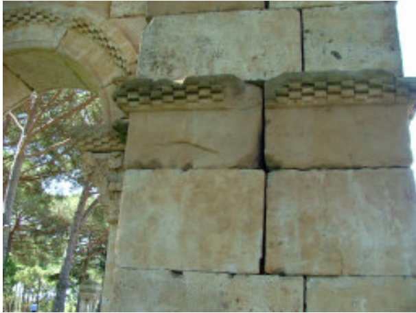
Carreus i dovelles afectats per ruptures semi circulars en les vores i cantonades.
