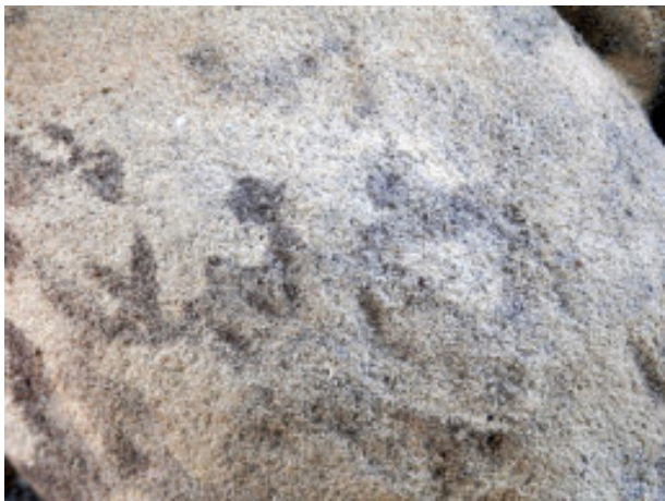
Restes d'activitat biològica del que semblen colònies de fongs o líquens tractats per un biocida de Cu i probablement erosionats per un tractament mecànic.
