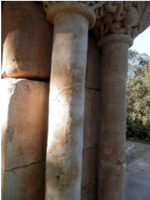
El morter hidràulic (de color rosat) està per sobre del morter bastard, de color blanc
