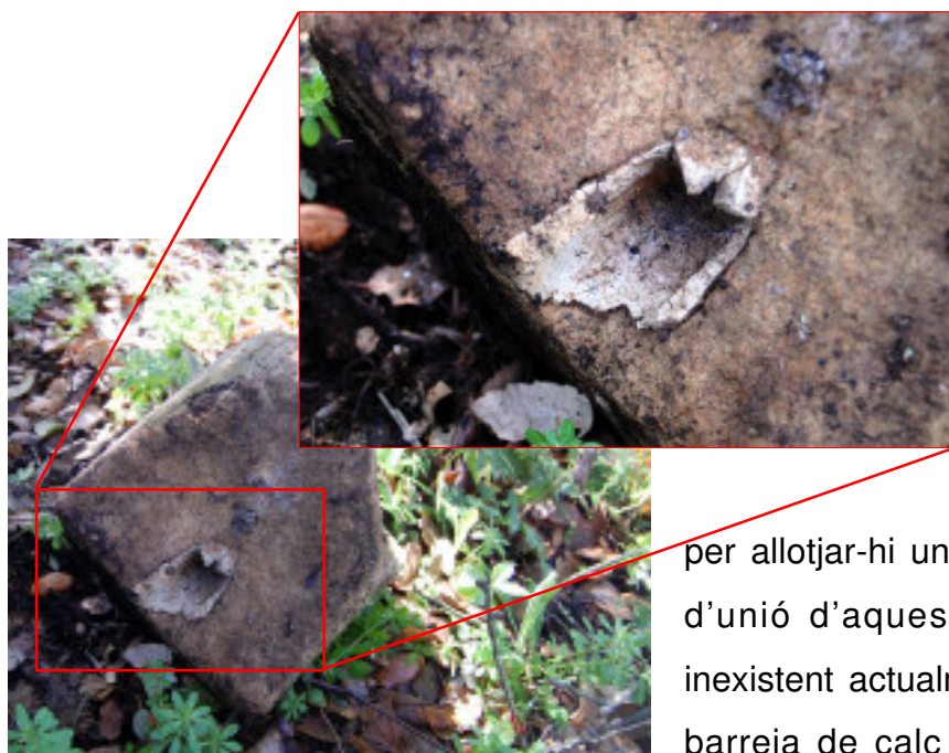
Morter mixt de calç i ciment pòrtland en un encaix de fust. Es tracta d'una resta del morter de muntatge a Ciudad Lineal.
