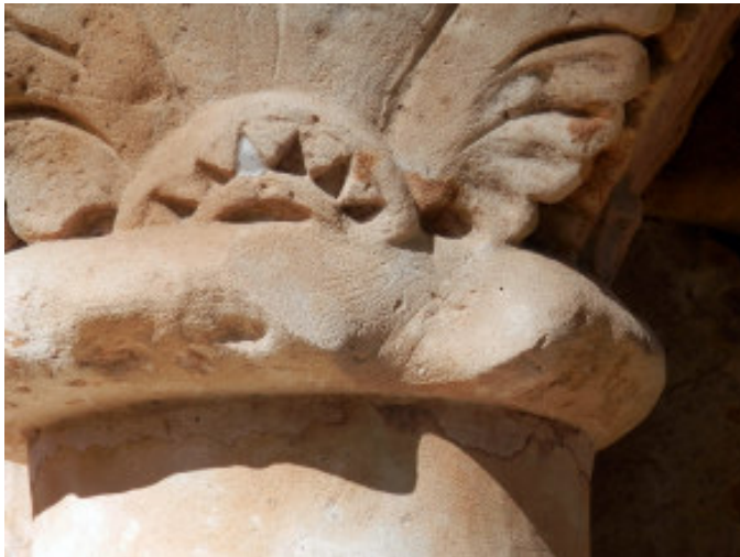
Noteu les marques d'erosió dels collarins de sengles capitell.
