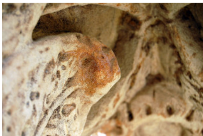
Detall d'un dels capitells on s'ha observat un recobriments artificial amb una argila rica en òxids de ferro (pigment terra), calç i un component orgànic.
