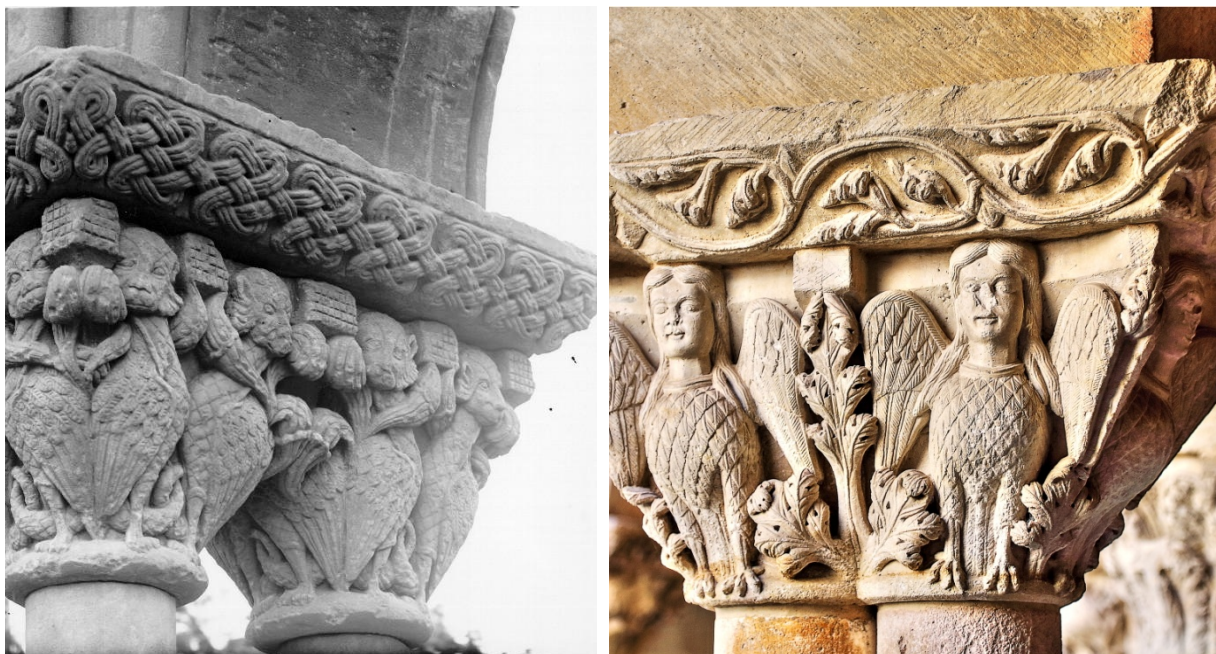
19 y 20.- A la izquierda capitel de Palamós, donde se aprecia la rudeza de la labra de la piedra, raspada para disimular la huella de la talla. A la derecha capitel de Silos con labra extraordinariamente fina de gradina; se aprecia claramente la huella de la característica labra oblicua con trinchante en las superficies lisas.
