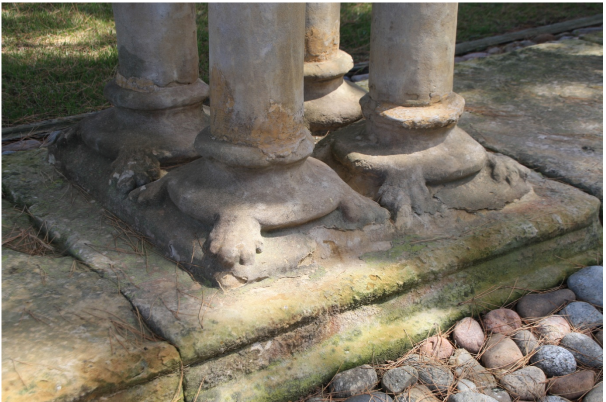
17 y 18.- Dos pormenores de basas del claustro de Palamós, en los que se puede apreciar la forma en que están talladas las basas y el basamento de asiento en un mismo bloque pétreo. Esto supone una absoluta incoherencia constructiva que ningún cantero medieval llevaría a cabo; todo indica que están realizadas mecánicamente. Arriba basa con garras de bola y abajo garras vegetales.
