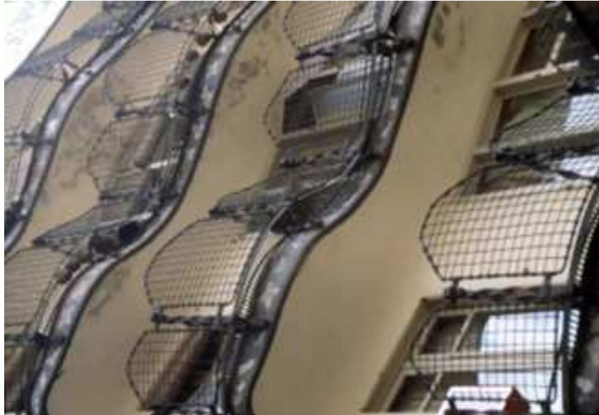
Detall façana posterior casa Batlló
