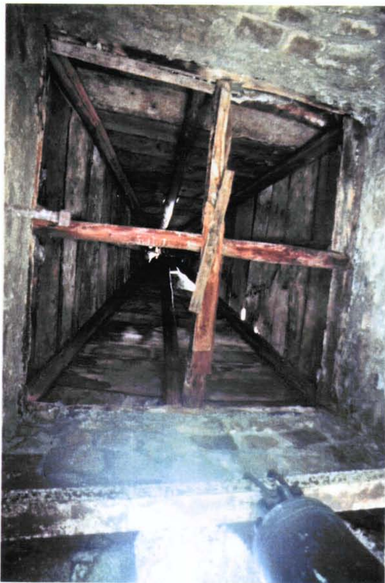
16. Campanar. Visió interior de la coberta
