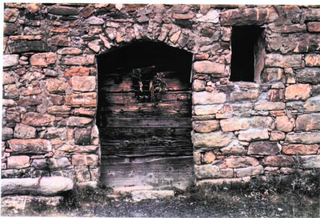
7. Detall porta d'accès. Façana est
