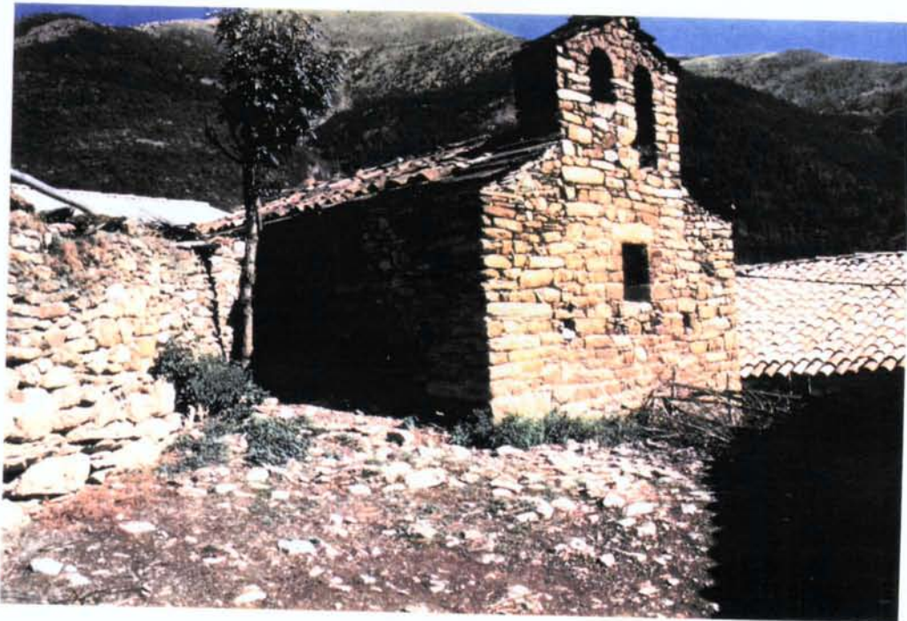
6. Visió parcial de les façanes nord i est
