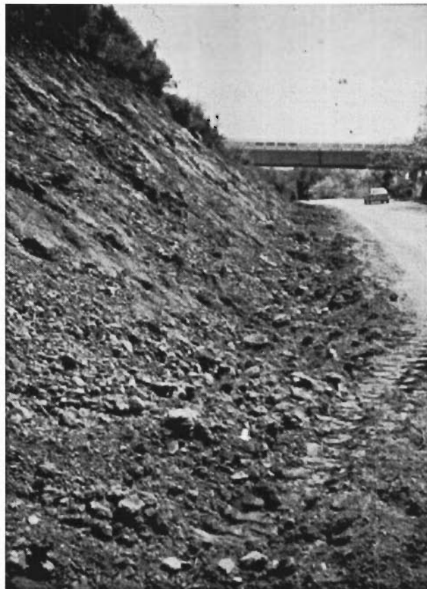
Detall de la intervenció núm.10
