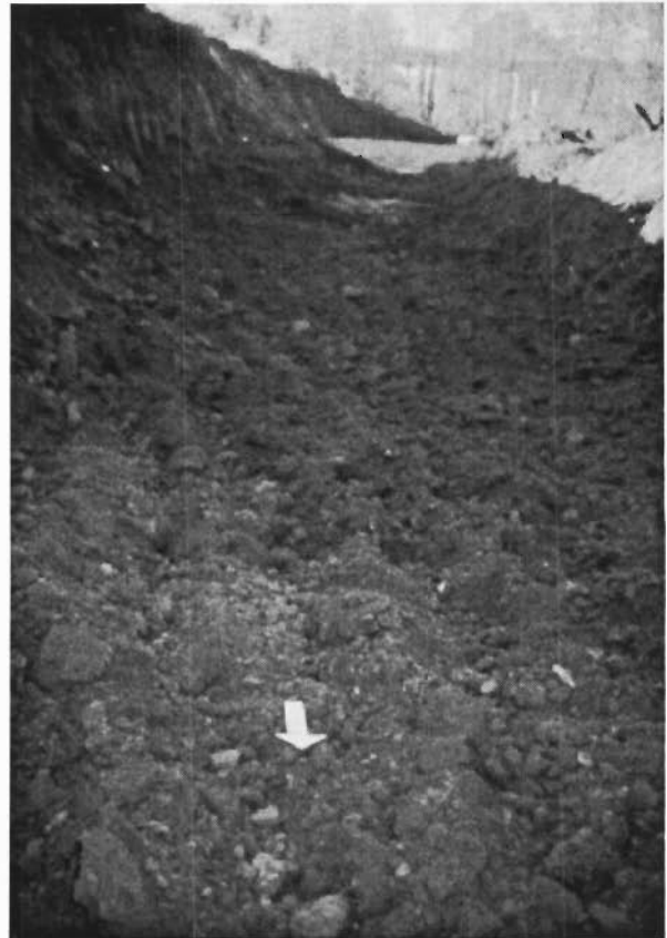
Detall de la intervenció núm.9
