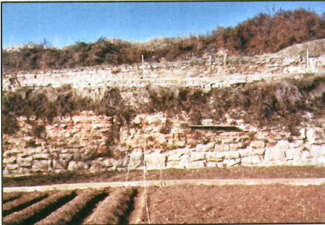
Detall del parament de la sèquia al seu pas per Balsareny
