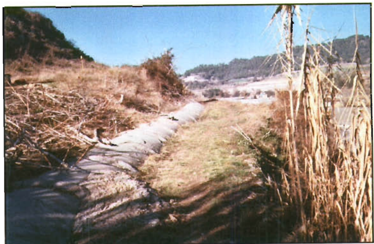
Vista de la sèquia amb el tub de ciment que la tapa
