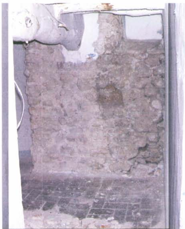
13. Mur meridional (cantonada)
