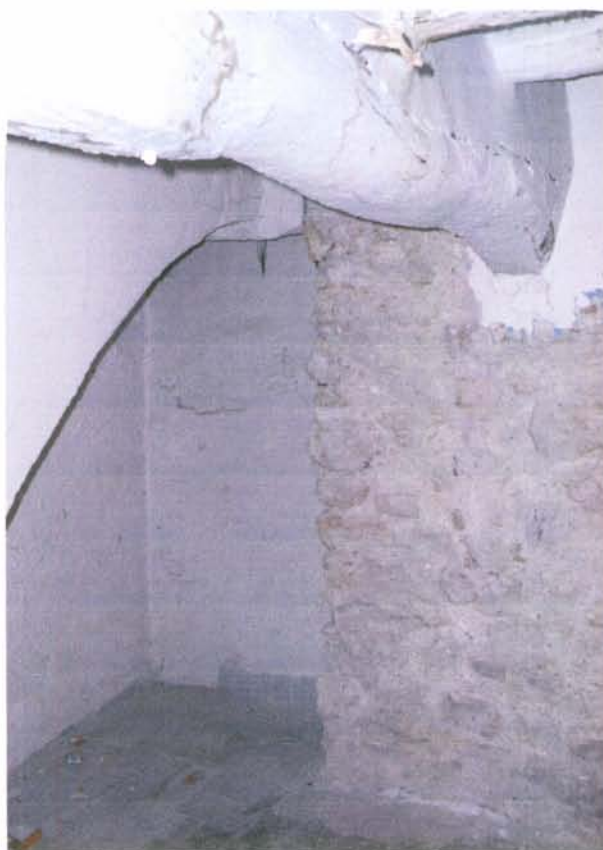
15. Mur meridional (cantonada)
