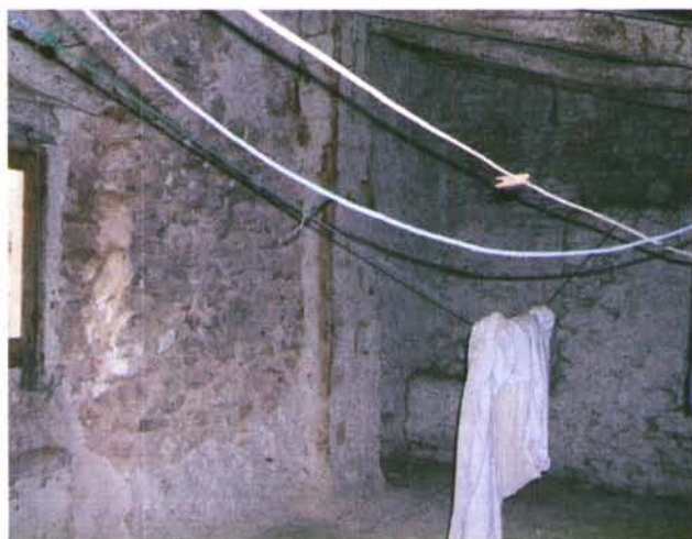
16. Murs meridional i occidental.
