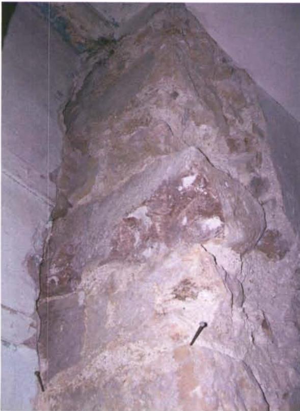
7. Detall del mur meridional
