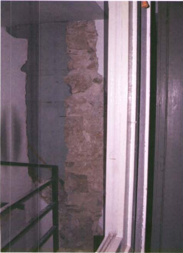
5. Mur meridional (cantonada)
