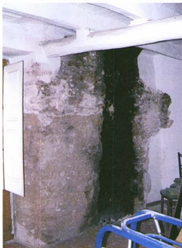
11. Mur meridional. Parament de tàpia.
