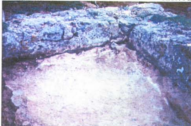
A.10. Detall de les restes del placat de marbre original
