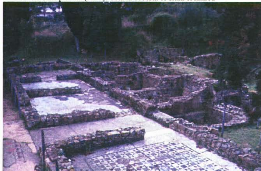
Façana est del bloc central de l'edifici, l'any 1999
