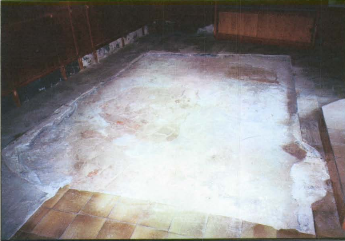
Foto.1: Detall del paviment de rajols de terracuita u.e.4.
