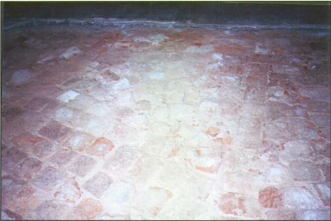
Foto.3: Detall del paviment de rajols de terracuita u.e. 4.
