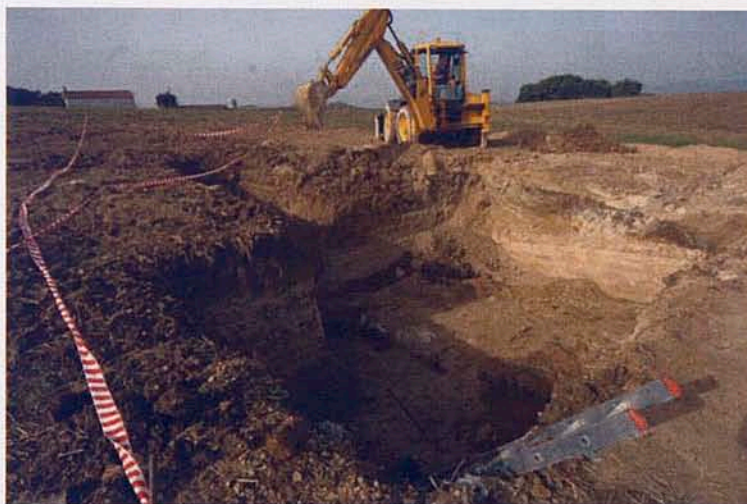
Fig. 14 Àrea d'excavació. Neteja de la planxa de calcària.
