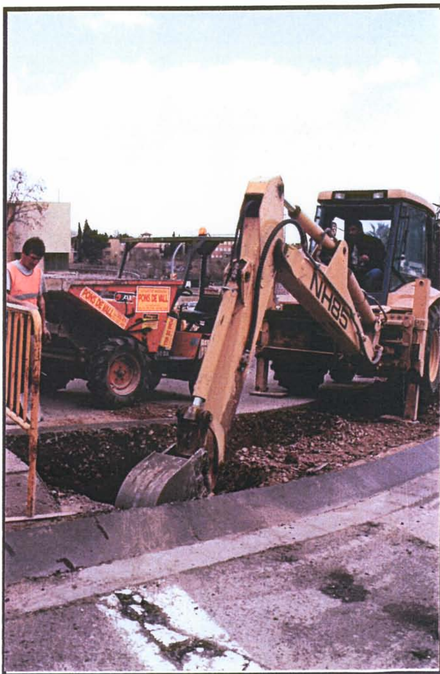
9. Vista general desdel sudoest dels treballs realitzats a la R-5 amb la retroexcavadora i l'obrer que ajuda al maquinista en les tasques manuals.
