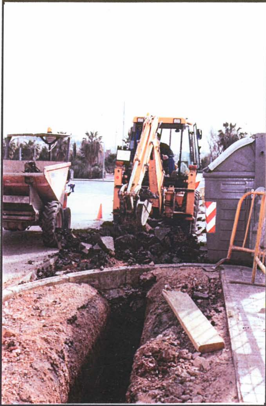
2. Mini retroexcavadora aixecant l'asfalt del carrer Berruguete. R-3. Foto presa desdel sudest.
