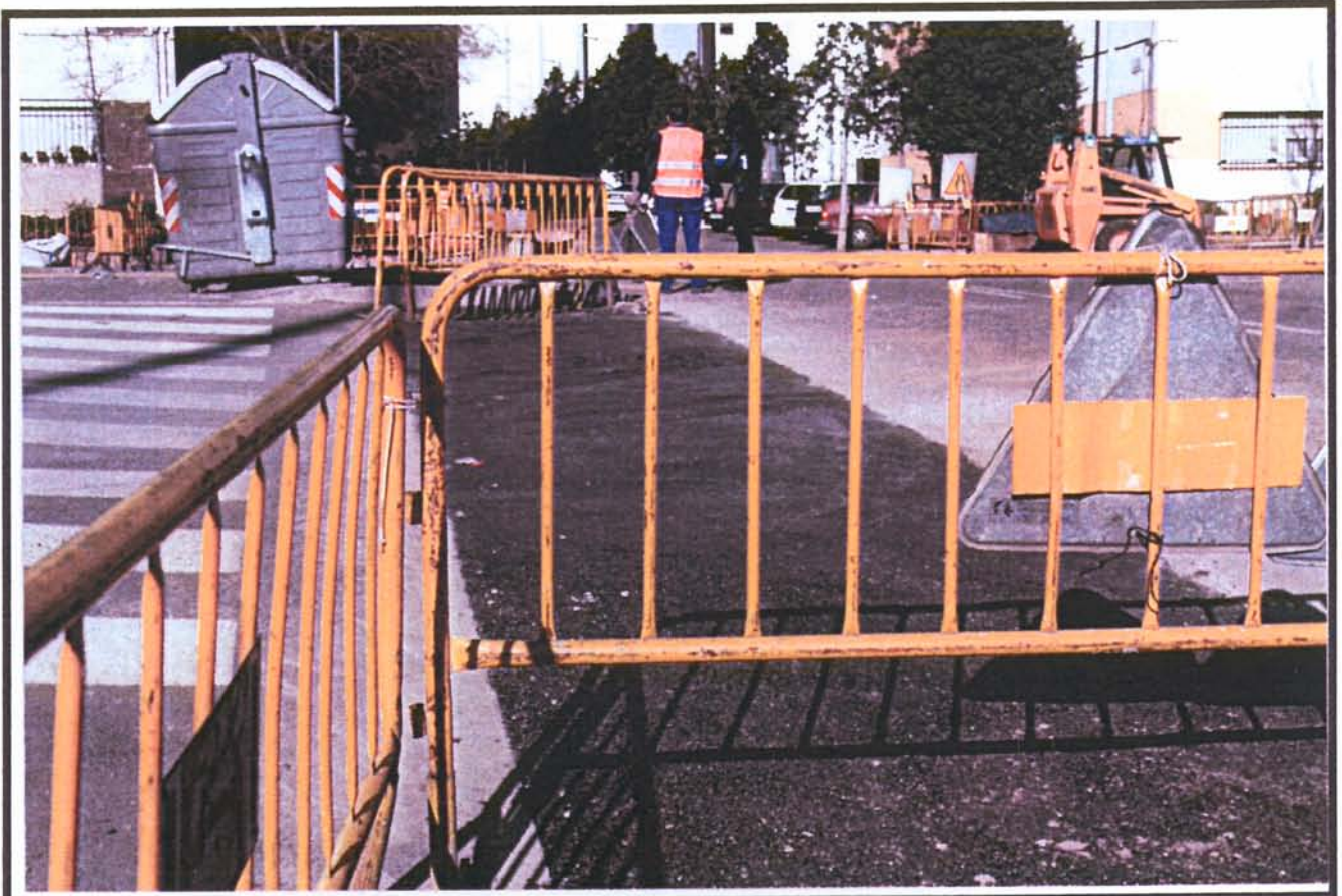
8. Detall de la R-3 un cop tapada amb el ciment sec. Foto presa desdel sud.
