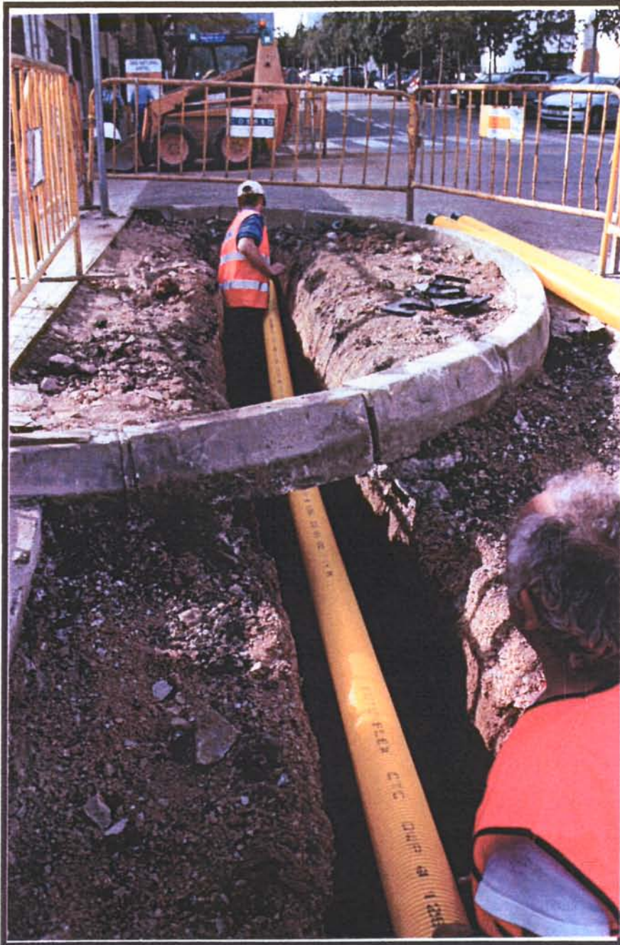
5. Obrers posant els tubs que portaran el cable telefònic de la R-3. Foto presa des del sud.
