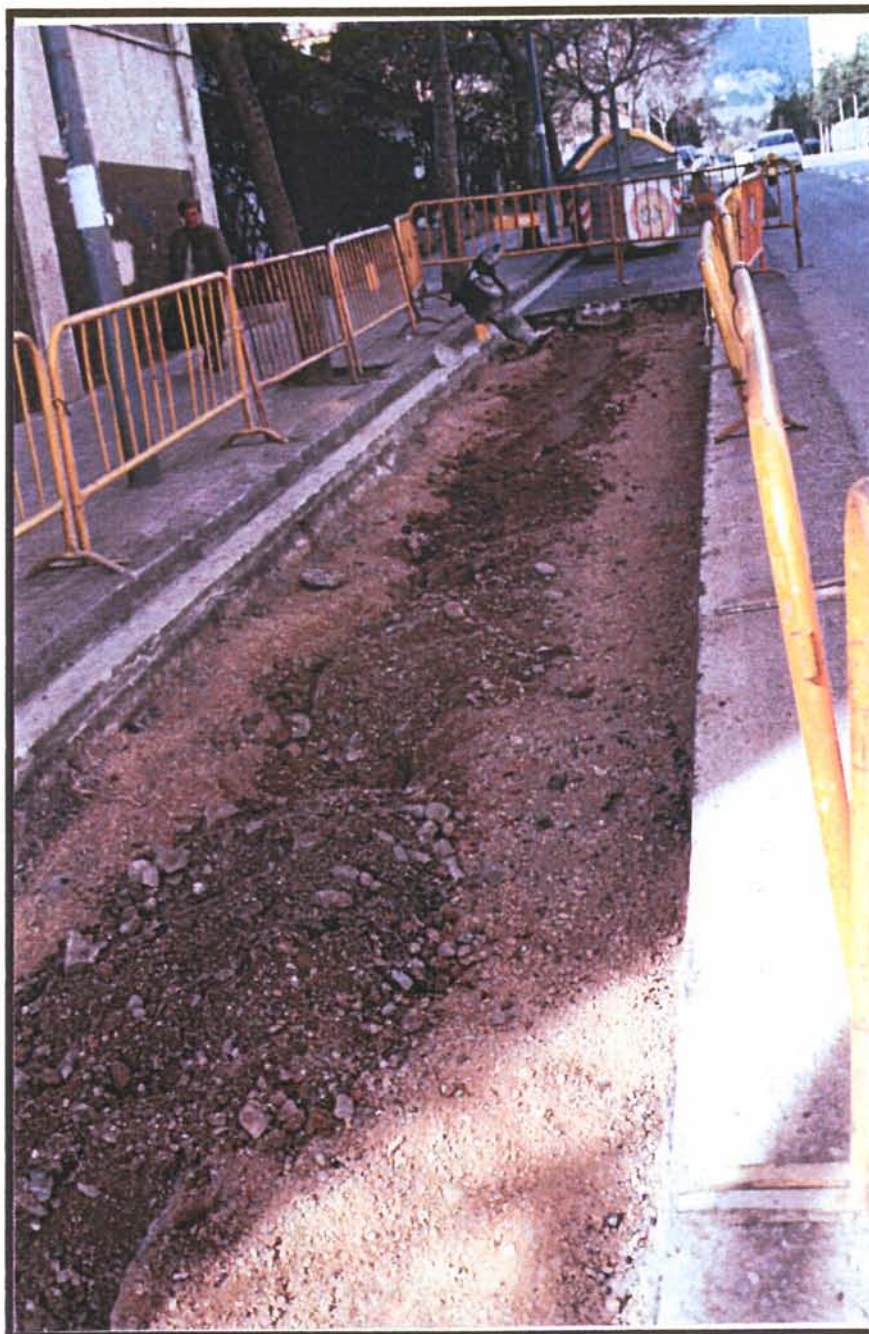
7. Vista general desdel sudoest de la R-1 un cop tapada amb el sauló.
