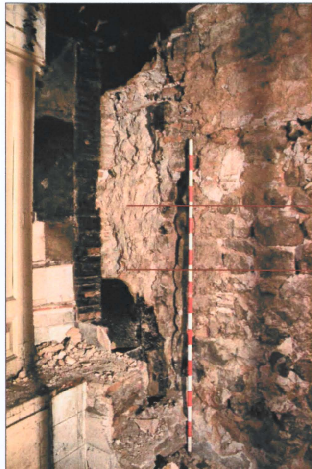
Vista general i localització en planta de la secció del segon pis de la torre romana del portal de Regomir descoberta en la mitgera de la cuina del primer pis de l'edifici.
