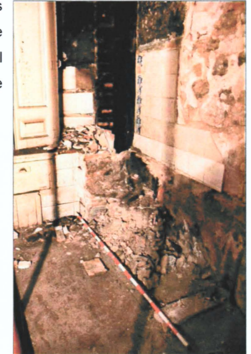
Dues vistes de les feines de desmuntatge i aterrament del moble d'obra de la cuina i de l'envà que cobria la paret mitgera
