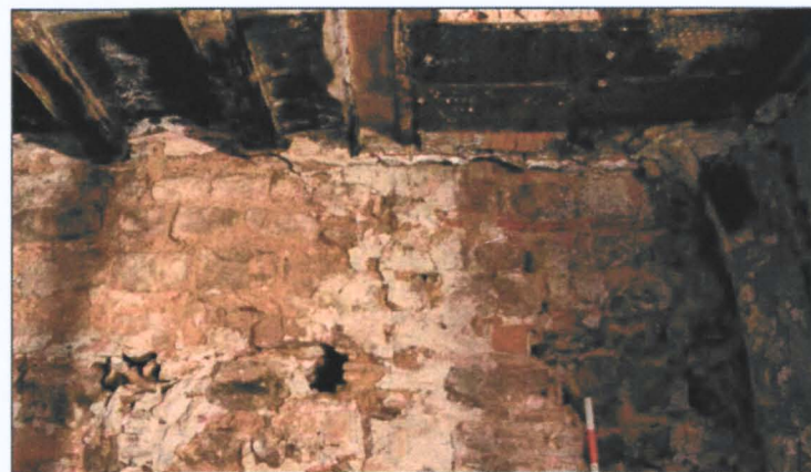
Vista parcial del parament. Notem a la dreta la filada reguladora de maó massís
