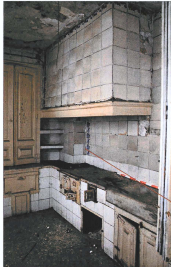
Vista parcial dels elements propis de la cuina que treballaven amb la paret mitgera que es repicà
