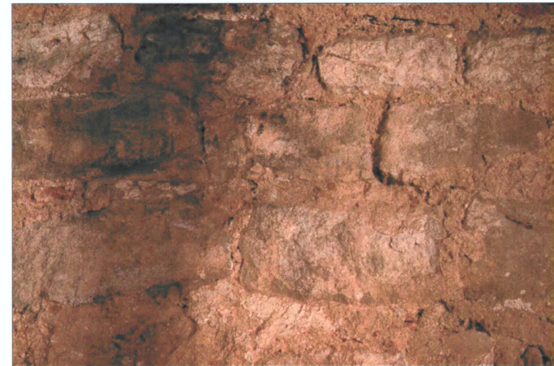
Detall del parament. Podem distingir l'estereotomis dels carreus i les característiques granulomètriques del morter de calç argilós
