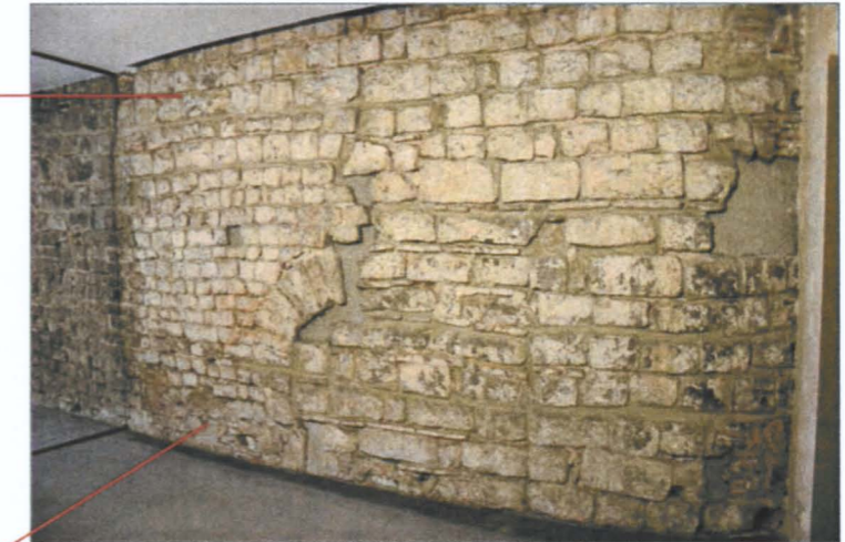
Vista general del parament corresponent al segon pis de la torre romana a la seva cara més septentrional. Podem observar els testimonis de l'"opus vitatum" i part d'una de les finestres que s'obria en direcció a l'interior de la ciutat
