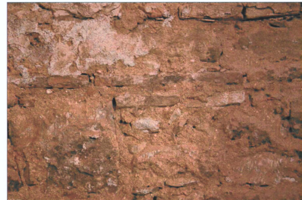
Detall del parament. Podem distingir la presència del maó massís de 2,5/ 3 cm. de gruix, un material constructiu pròpi de l'edifici barcelonina d'època moderna
