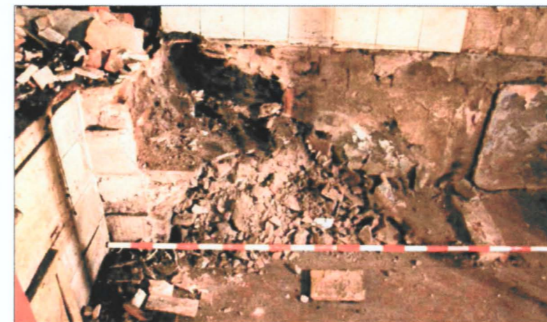
Dues vistes de les feines de desmuntatge i aterrament del moble d'obra de la cuina i de l'envà que cobria la paret mitgera
