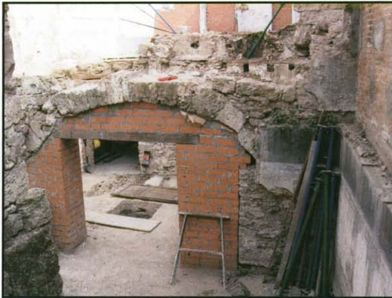
Foto 8. Vista general de la façana que dóna al pati. Foto feta des del nord-est.
