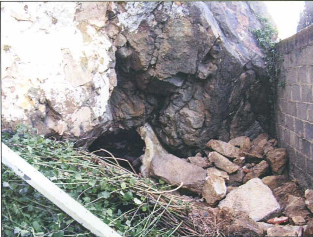
Foto 2. Estat en que es localitzà el solar on es localitza la penya.
