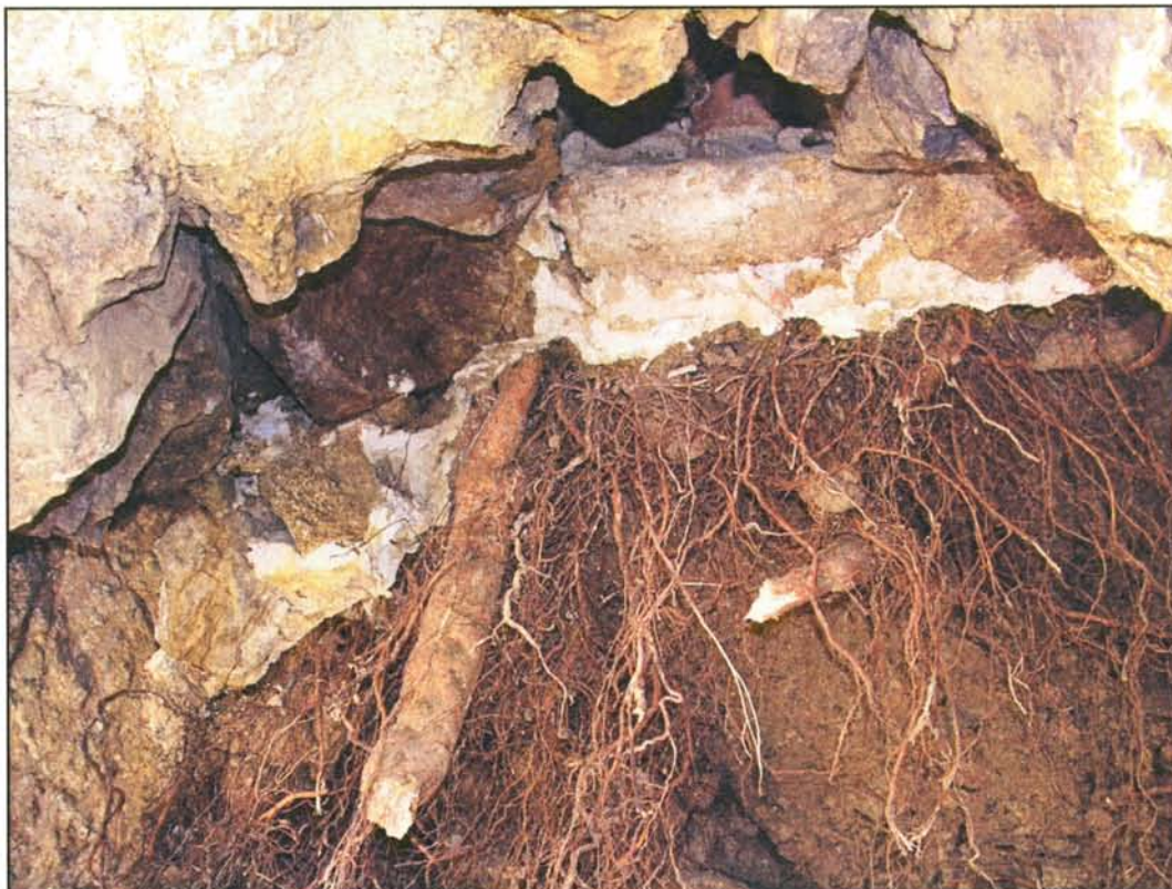
Foto 9: mur posterior i enlluït de calç a la part externa (UE 7).
