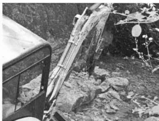
Figs.15-18. Procés de fragmentació i extracció de la llosa-visera.
