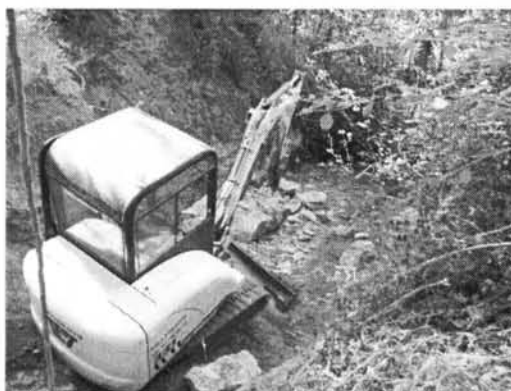
Figs.15-18. Procés de fragmentació i extracció de la llosa-visera.
