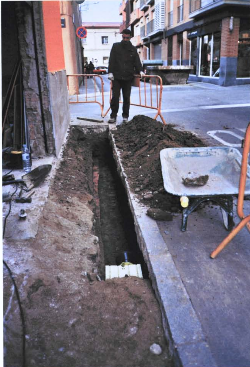
Fig. 4: Tancament de la rasa.
