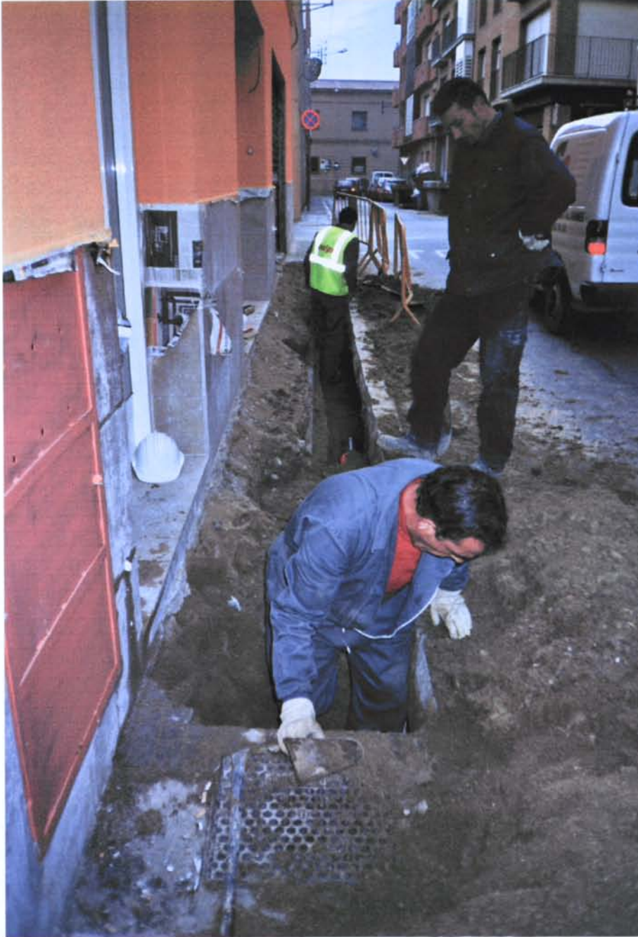
Fig. 2: Col·locació del tub .
