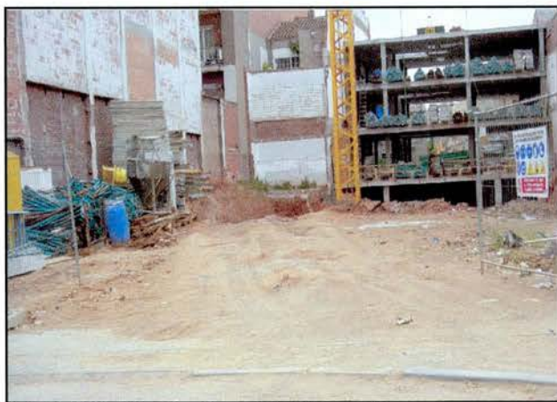
Foto 1. Vista del solar abans de la intervenció
