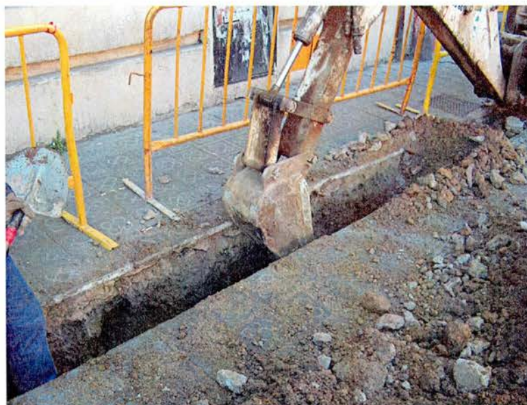
Foto 2: Obertura de la rasa a màquina.
